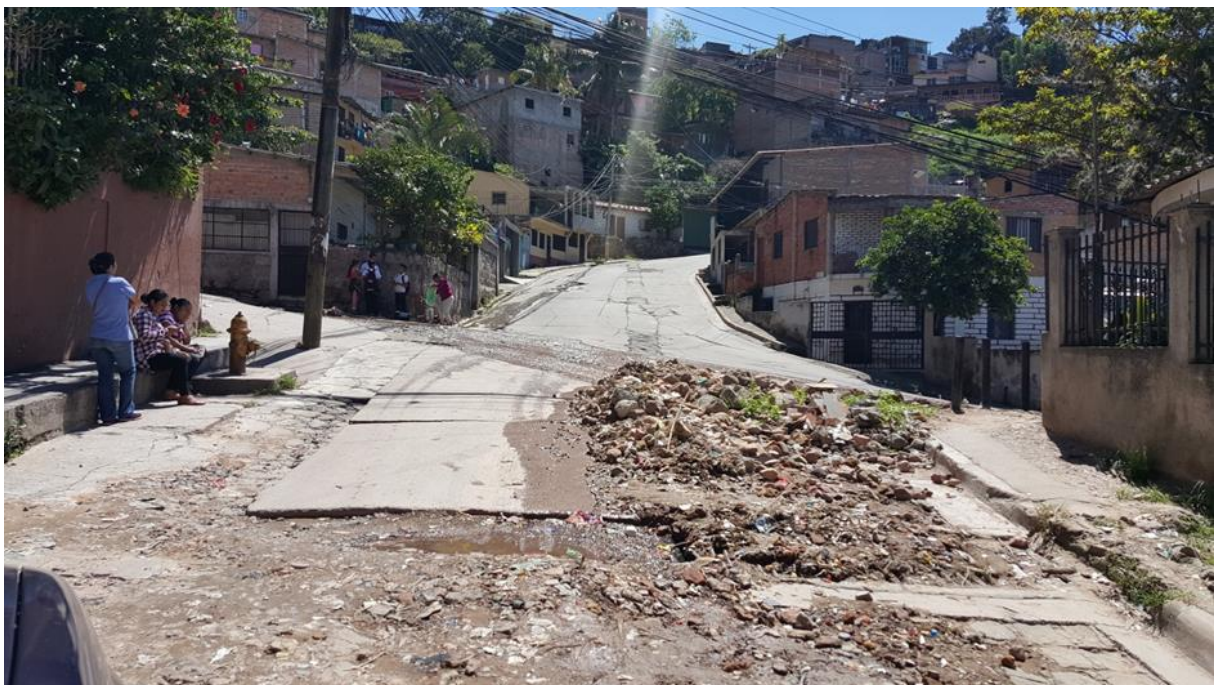
FINAL DE CALLE A PAVIMENTAR CON WHITE TOPPING Y EN DONDE SE CONSTRUIRÁ UNO DE LOS DRENAJE TIPO QUIEBRAPATAS
