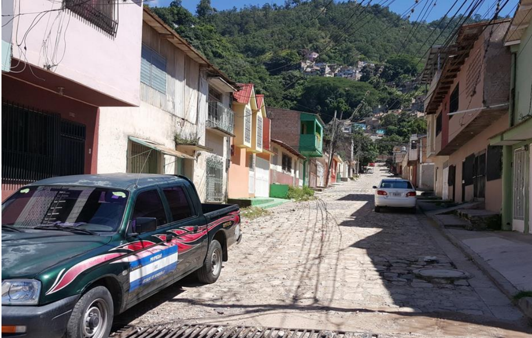
INICIO DE CALLE A PAVIMENTAR CON WHITE TOPPING Y EN DONDE SE CONSTRUIRÁ UNO DE LOS DRENAJES TIPO QUIEBRAPATAS
