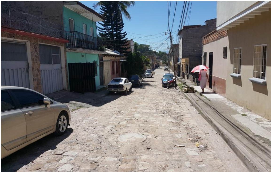
VISTA DE POZO A NIVELAR
