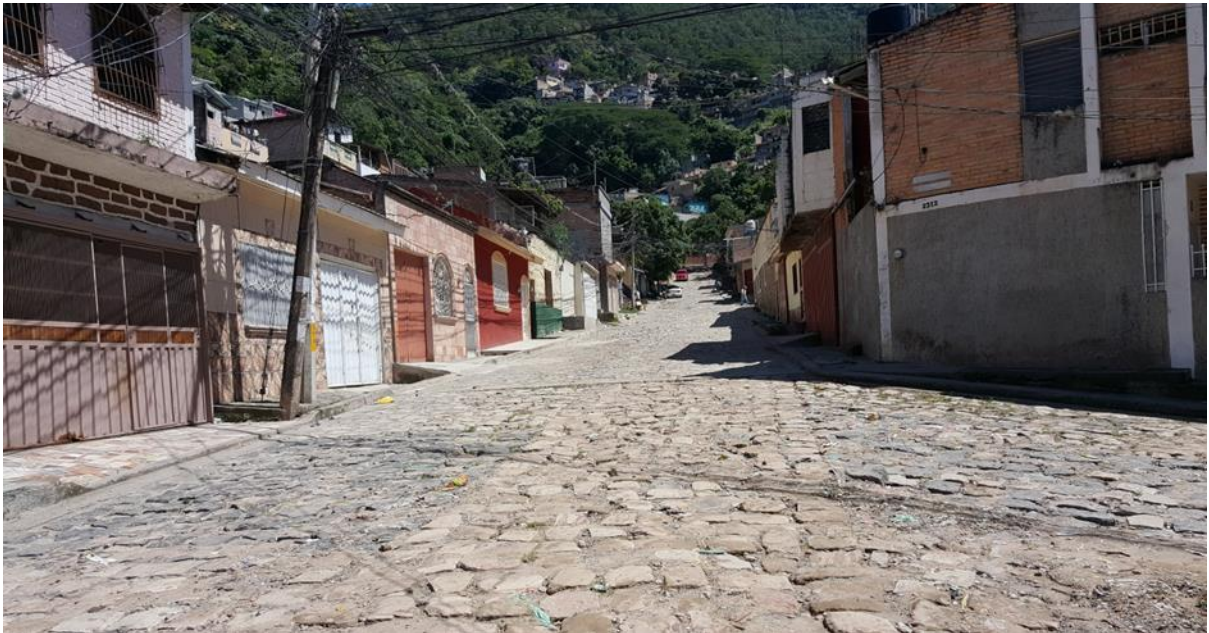
VISTA DE CALLE A PAVIMENTAR CON WHITE TOPPING
