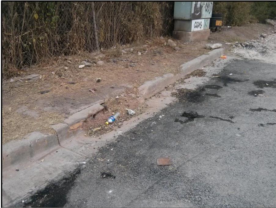
En la bocacalle de inicio que colinda con bulevar Los Próceres, se observó 2 tragantes azolvados y con daños, se requiere limpieza y reparación.
