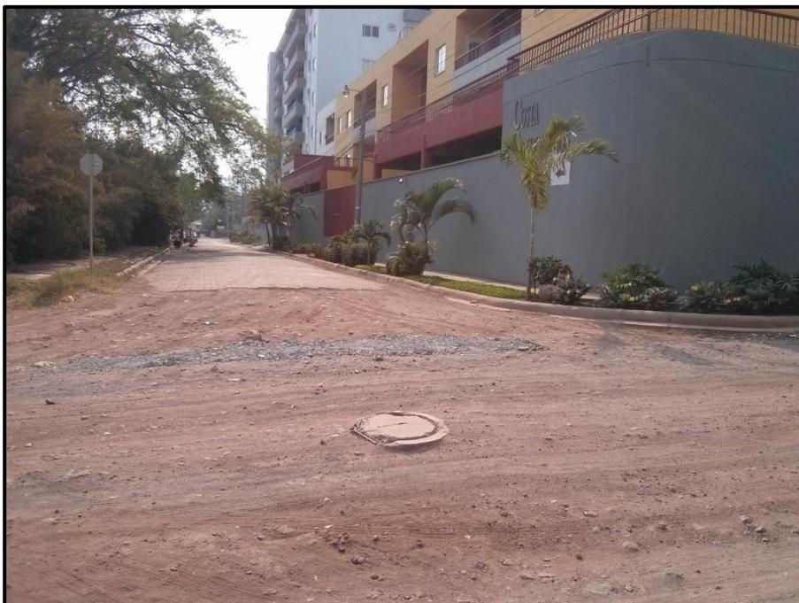
Se observa tapadera de concreto dañada en pozo de alcantarillado sanitario.
