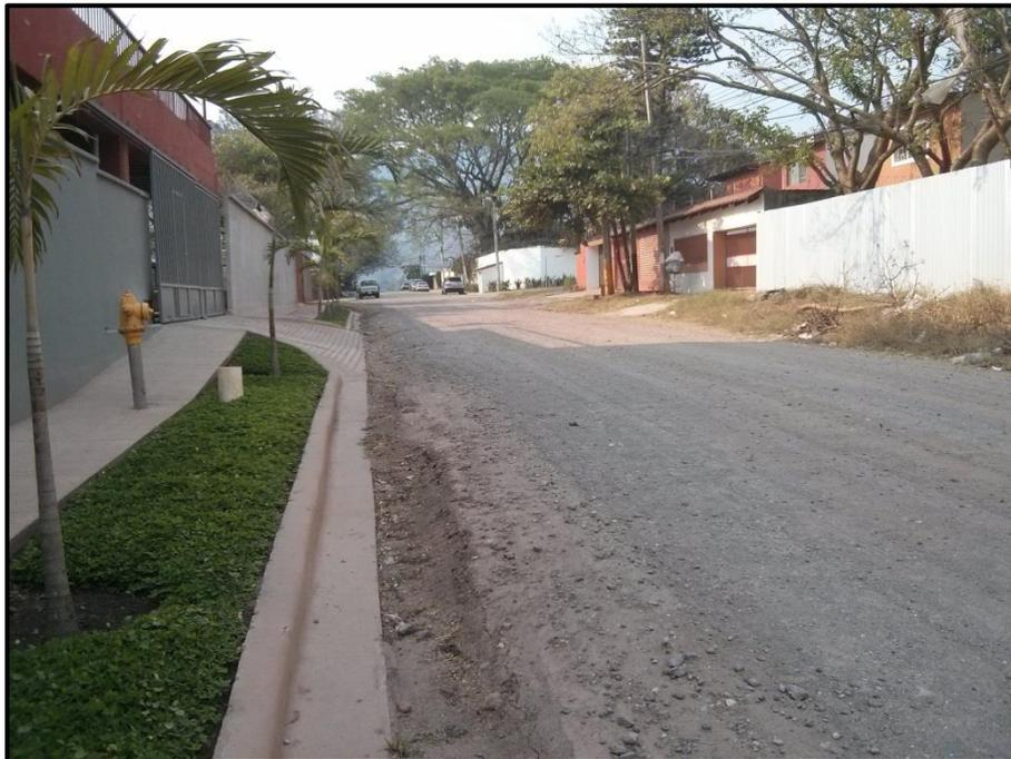
Se observa aceras y cunetas en lado izquierdo; lado derecho en toda su longitud requiere construcción.
