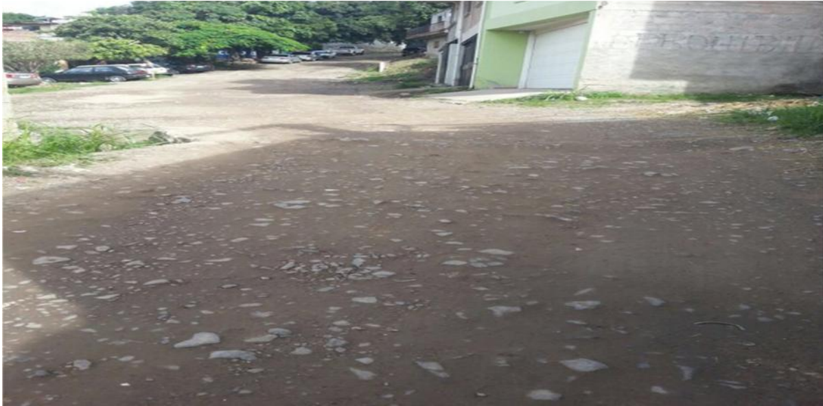
Inicio de calle a pavimentar
