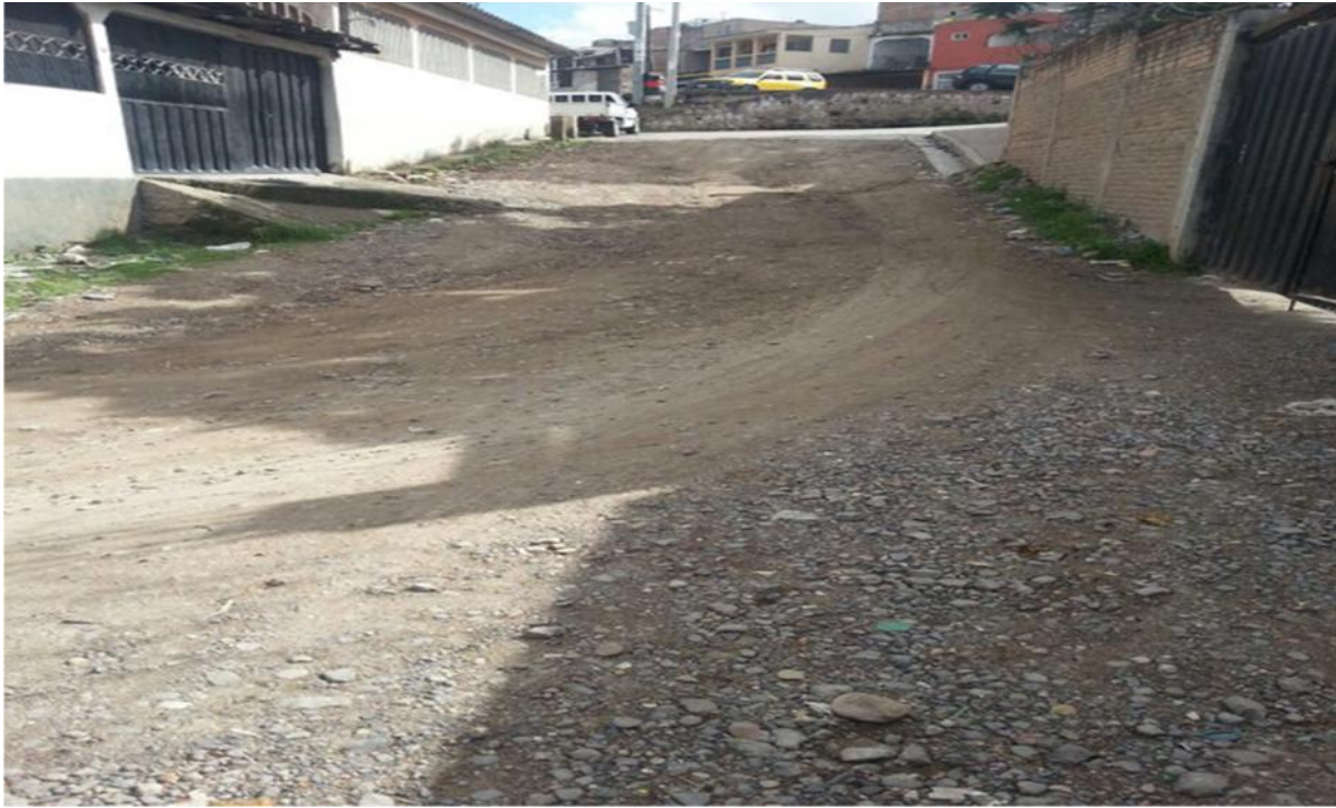
Vista de la calle a pavimentar
