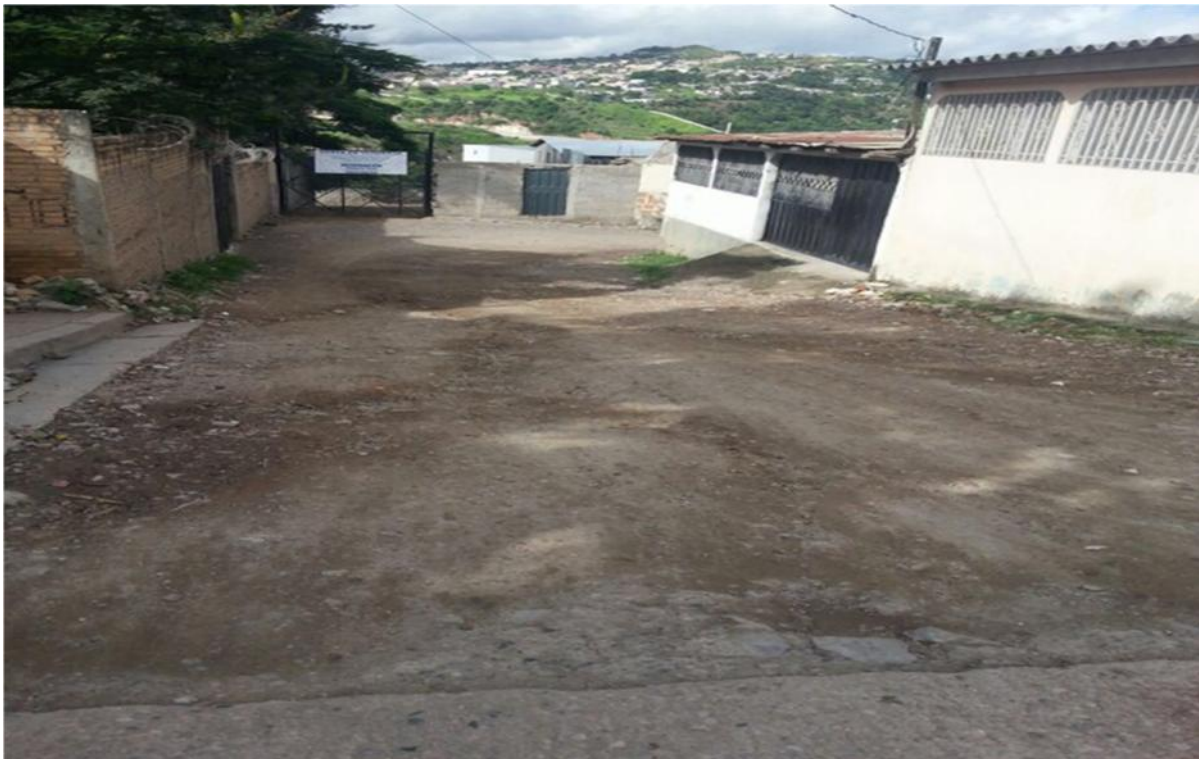
Vista panorámica de la calle a pavimentar
