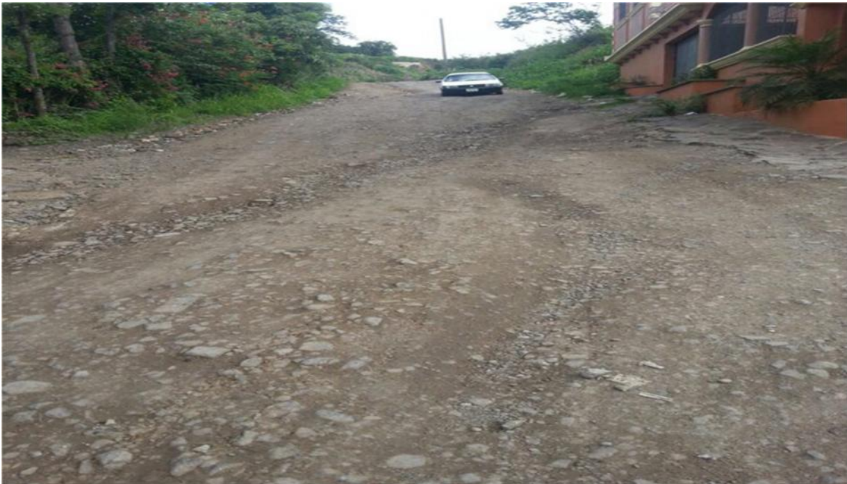
Final de calle a pavimentar
