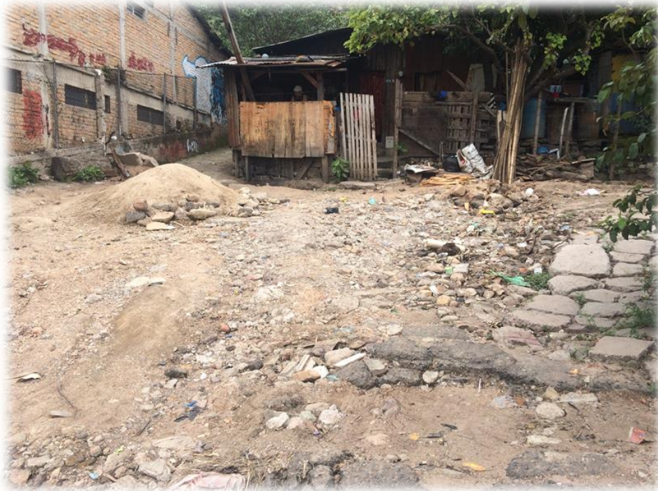
INICIO DE CALLE A PAVIMENTAR CON CONCRETO HIDRÁULICO
