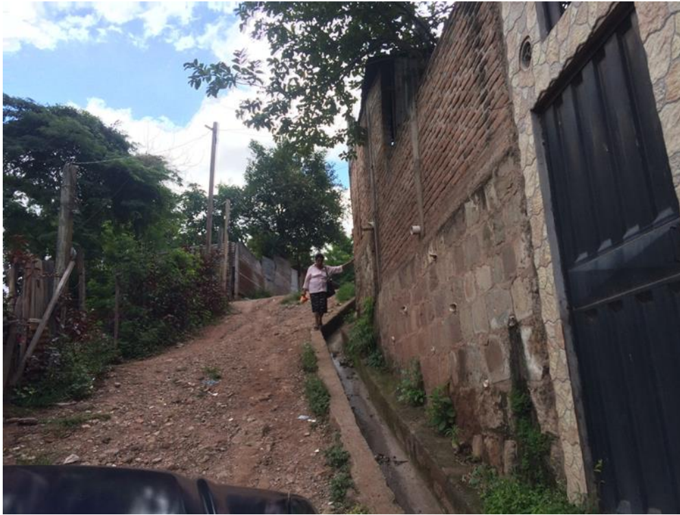
FINAL DE LA CALLE A PAVIMENTAR
