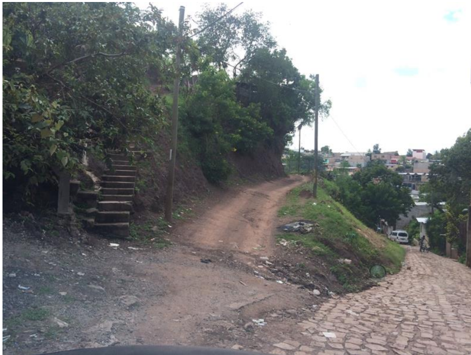
INICIO DE PAVIMENTACIÓN CON CONCRETO HIDRÁULICO.
