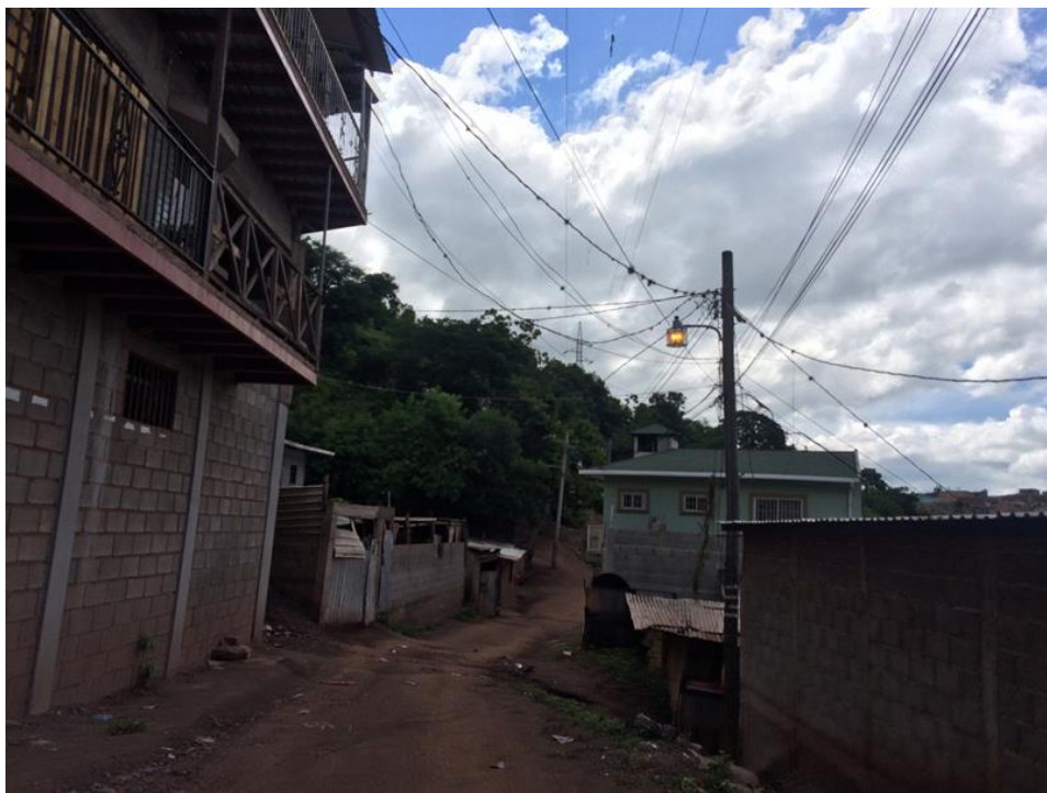
VISTA DEL ESTADO DE LA CALLE A PAVIMENTAR Y DE DONDE SE CONTRUIRA EL MURO 1
