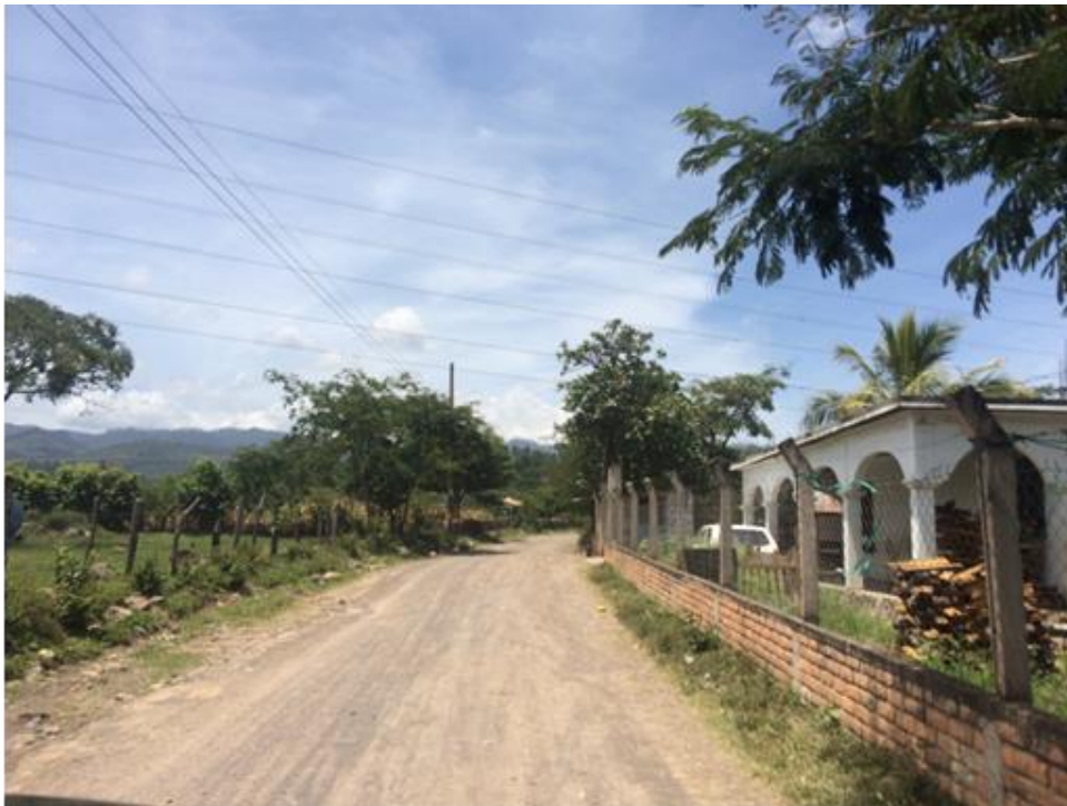
Vista de otro tramo de calle a conformar y balastar
