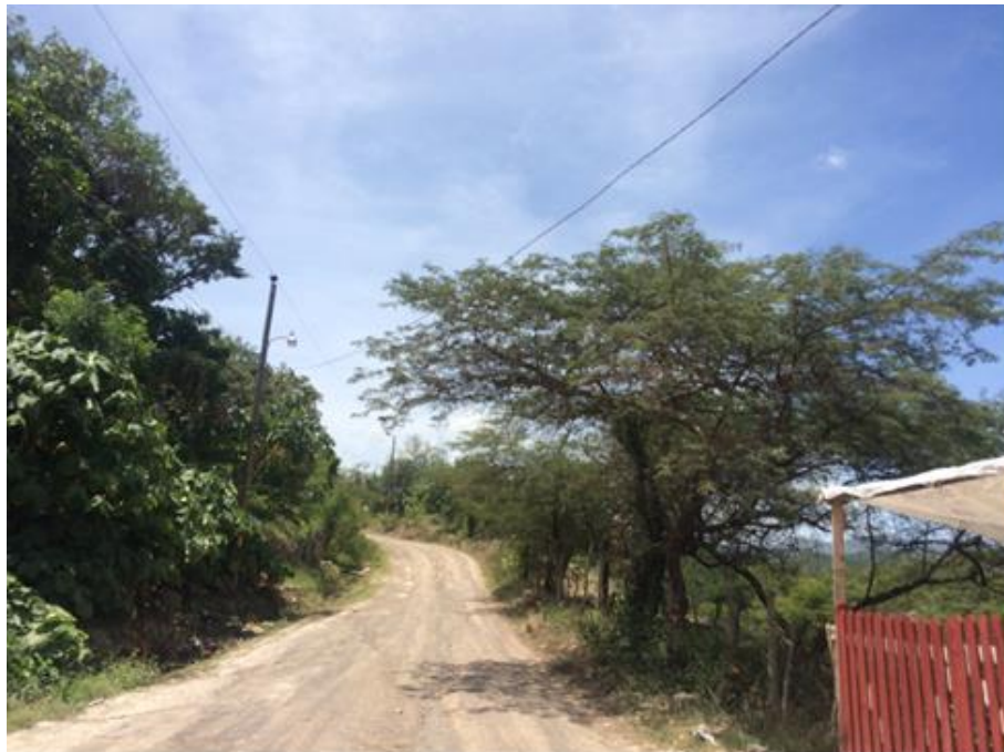
Se observan las malas condiciones en que se encuentra la calle
