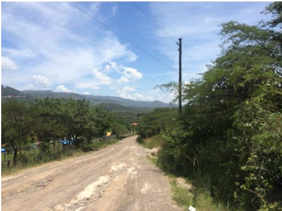
Se observan las malas condiciones de la calle debido a la escorrentía superficial
