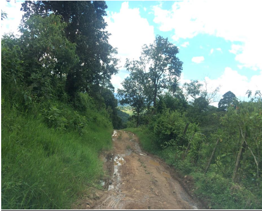
VISTA DE CALLE A REPARAR
