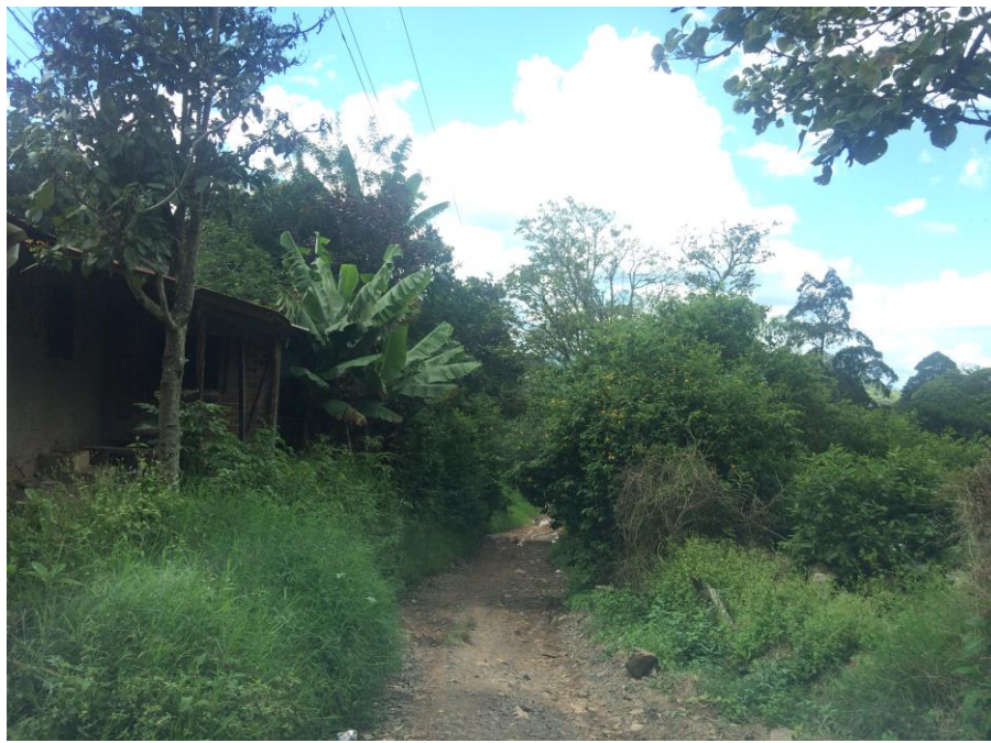
VISTA ACTUAL DE CALLE A REPARAR
