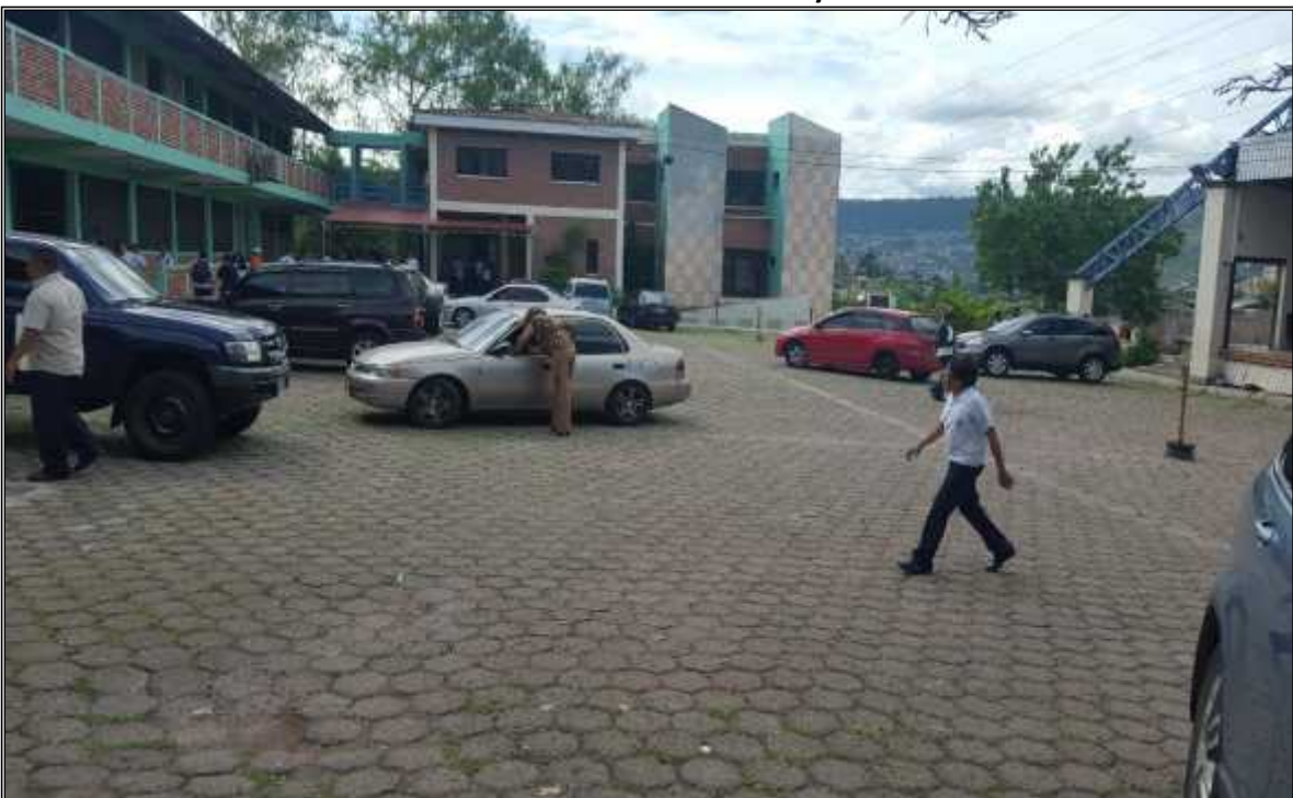
Vista panorámica del espacio donde se construirá el techo
