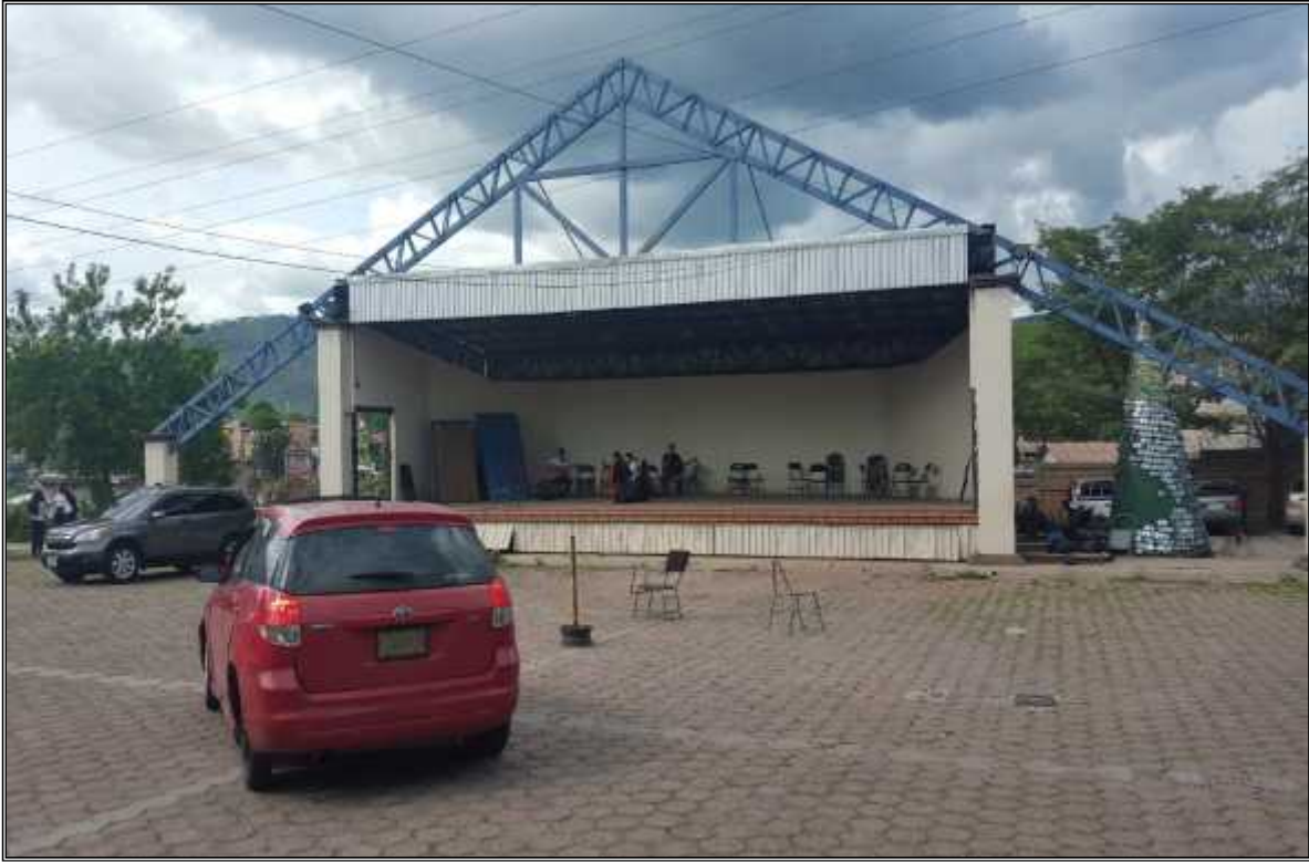
Vista del escenario existente ya techado
