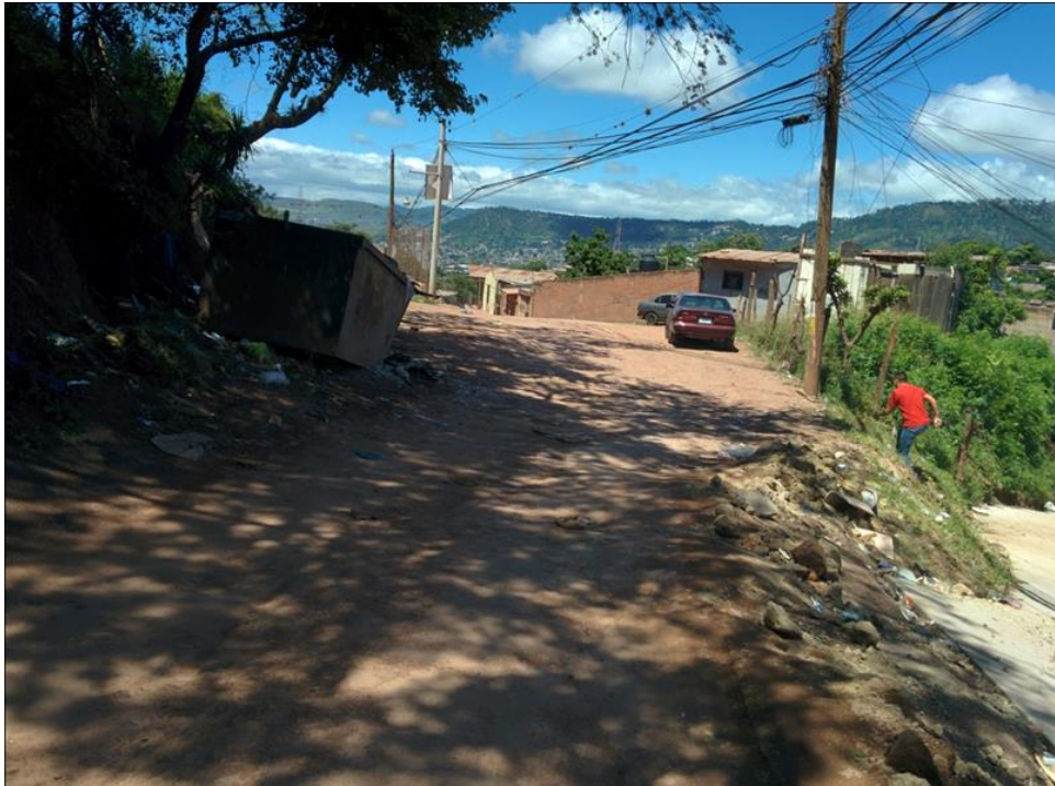
INICIO DE PAVIMENTACIÓN CON CONCRETO HIDRÁULICO.
