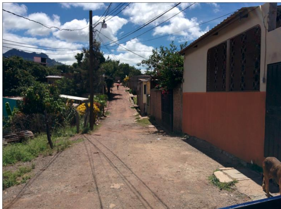
PANORAMICA A PAVIMENTAR CON CONCRETO HIDRÁULICO
