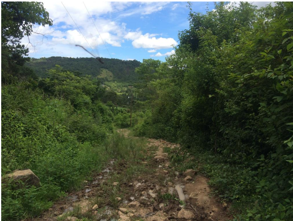
VISTA ACTUAL DE CALLE A REPARAR
