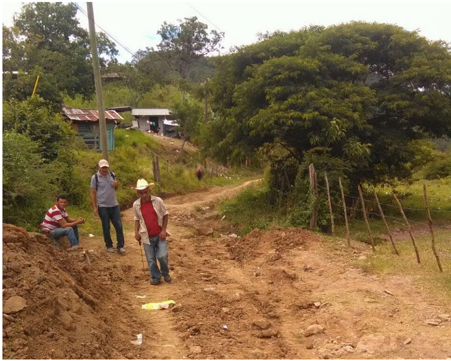
INICIO DE CALLE A REPARAR
