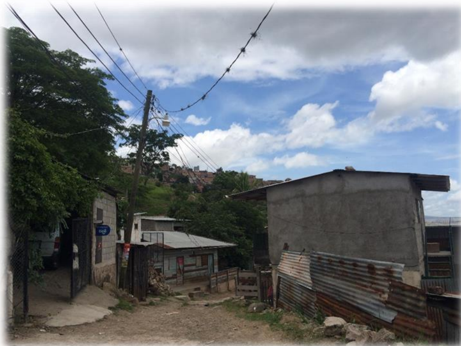
VISTA DEL TRAMO FINAL A PAVIMENTAR. TRAMO B
