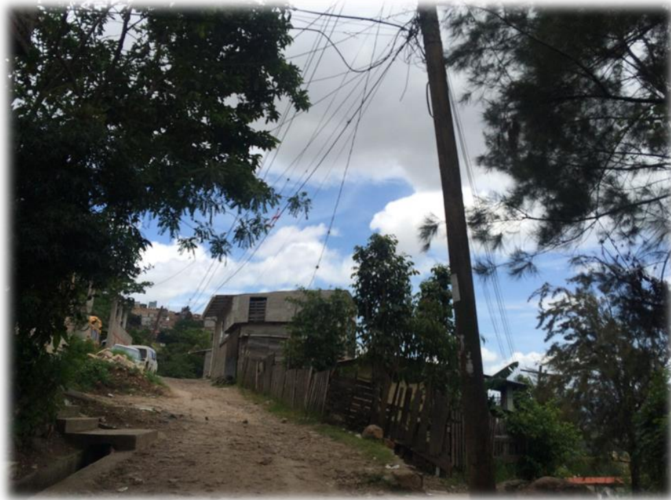
VISTA DEL ESTADO DE LA CALLE A PAVIMENTAR. TRAMO B
