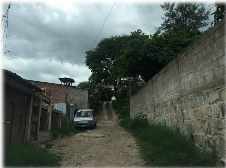
TRAMO A PAVIMENTAR CON CONCRETO HIDRAULICO, TRAMO A
