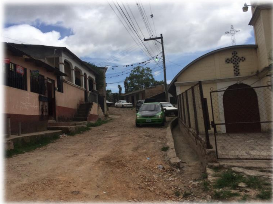
FINAL DE TRAMO A PAVIMENTAR. TRAMO A
