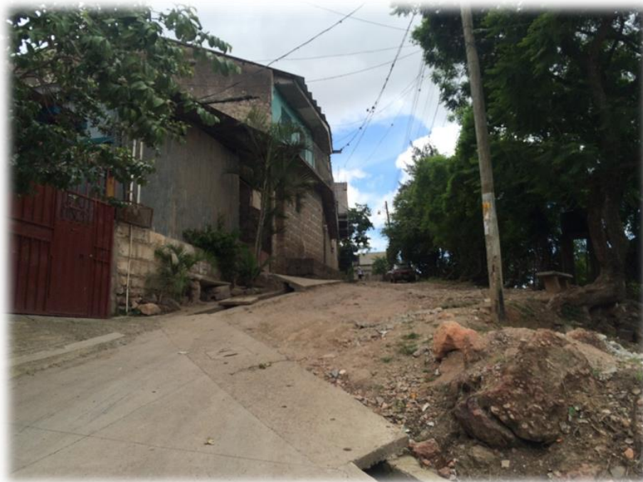
INICIO DE PAVIMENTACION CON CONCRETO HIDRAULICO. TRAMO B
