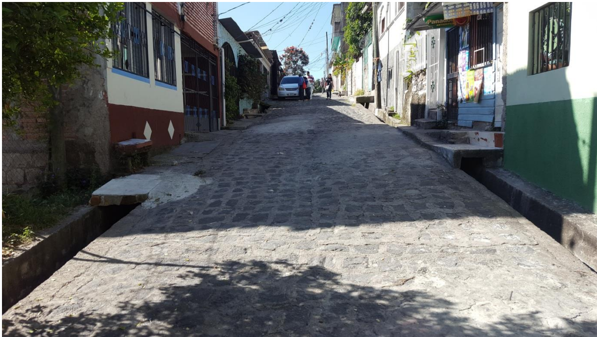
VISTA DE CALLE A PAVIMENTAR
