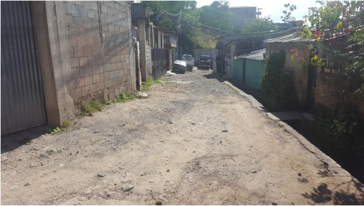
PANORÁMA DE CALLE A PAVIMENTAR CON CONCRETO HIDRÁULICO
