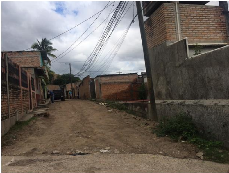
No. 4 PANORAMA DE CALLE A PAVIMENTAR CON CONCRETO HIDRÁULICO
