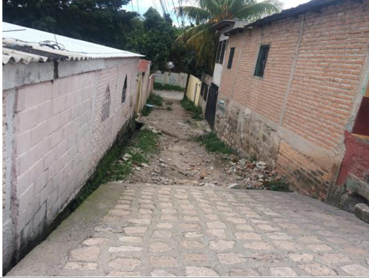
No. 3 FINAL DE PAVIMENTACIÓN CON WHITE TOPPING E INICIO CON CONCRETO HIDRÁULICO
