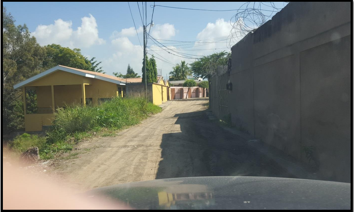
Vista final del tramo
