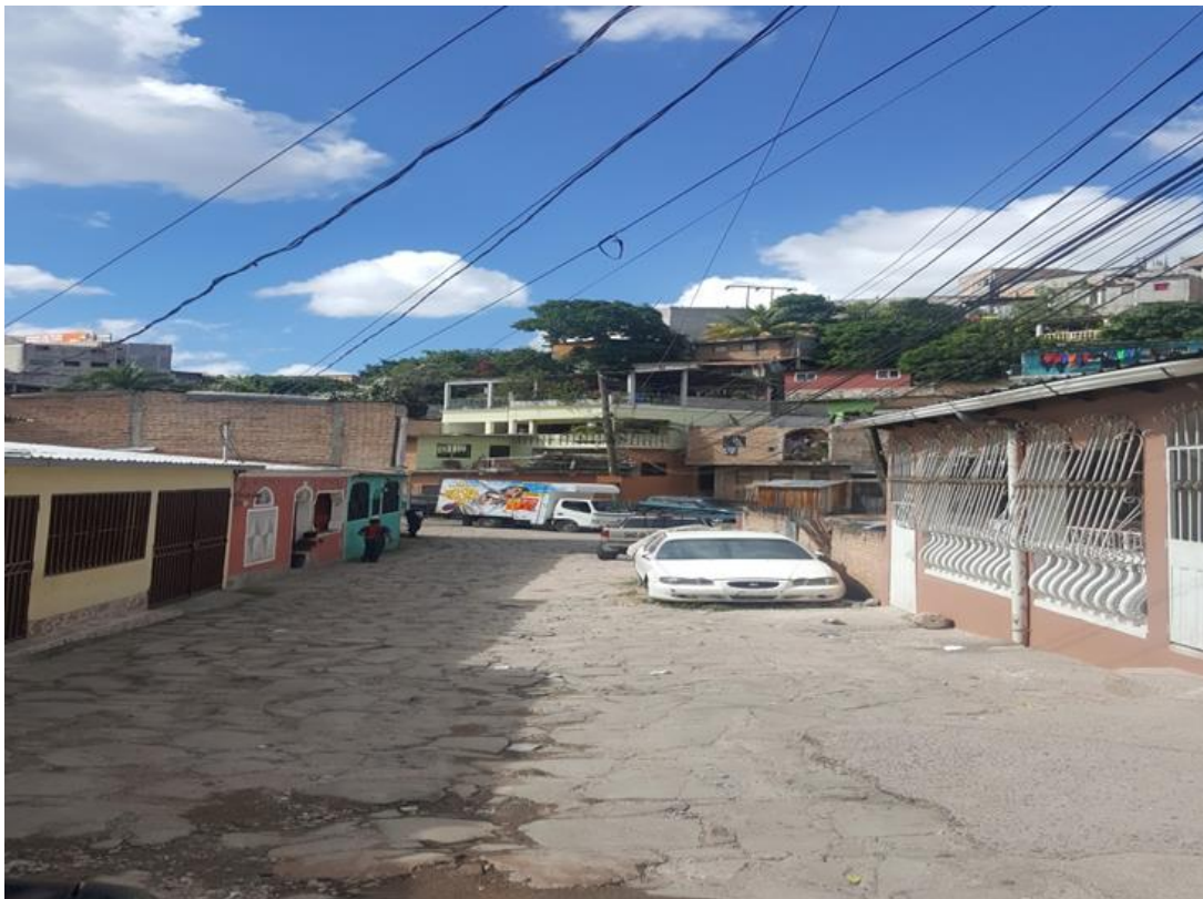
Vista de calle a pavimentar con white topping y en donde se construirán bordillos
