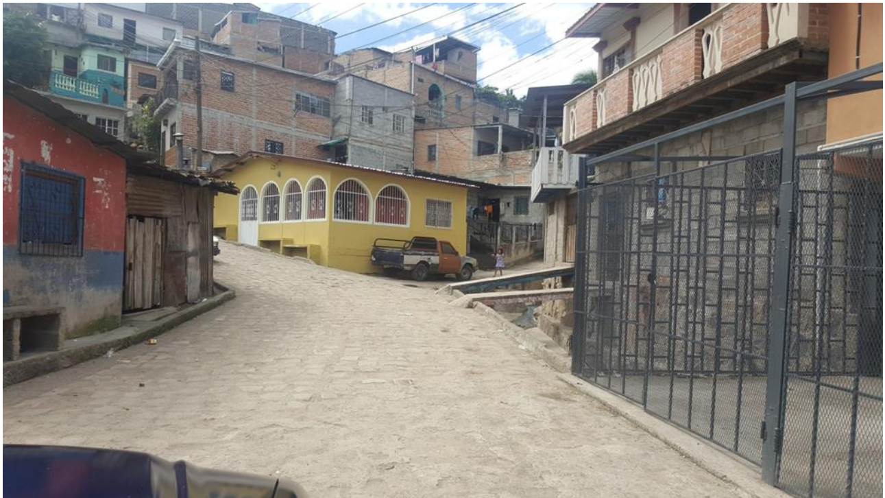
Vista de calle a pavimentar
