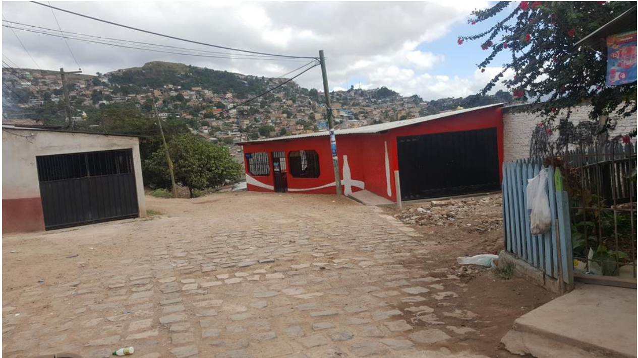
Final de calle a pavimentar con white topping
