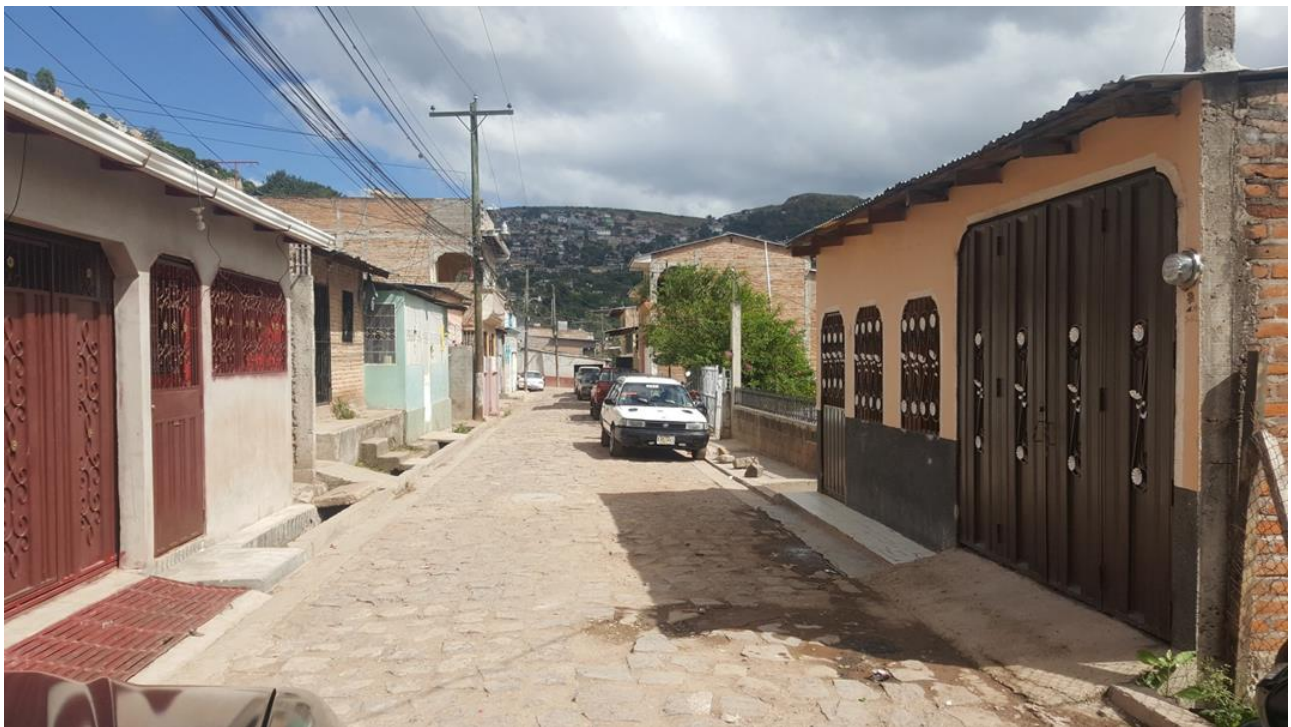
Vista de calle a pavimentar
