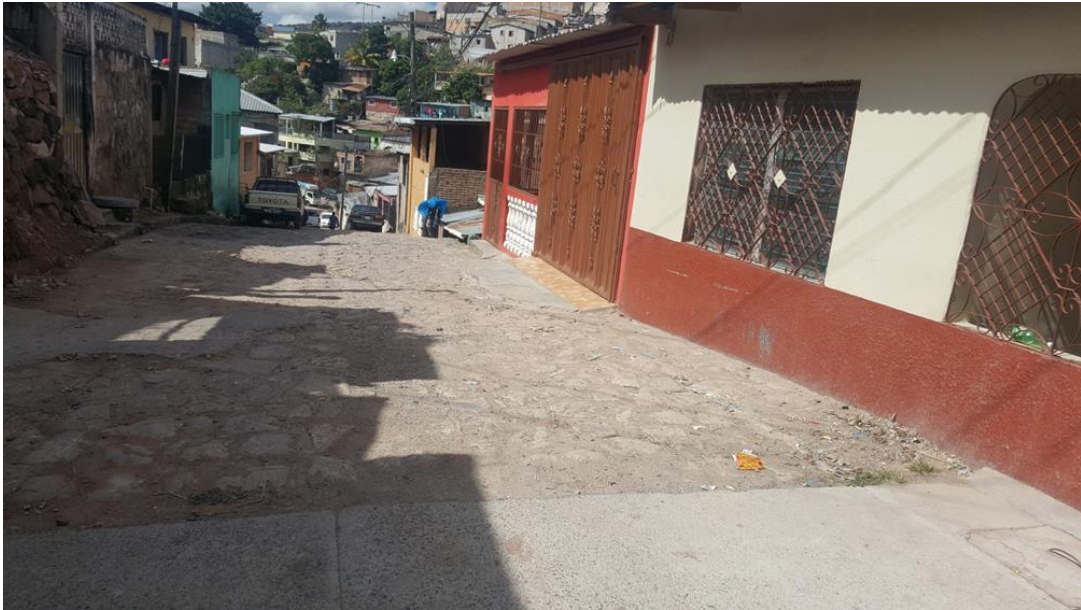
Inicio de calle a pavimentar con white topping y en donde hara la losa de transición
