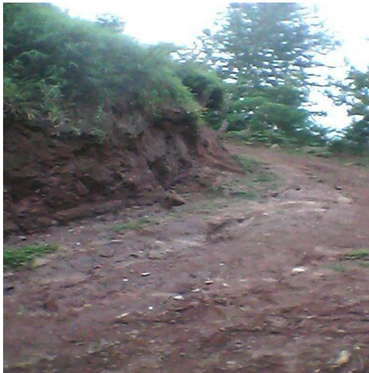
VISTA ACTUAL DE CALLE A REPARAR
