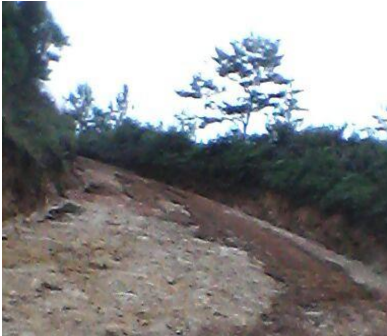
VISTA DE CALLE A REPARAR
