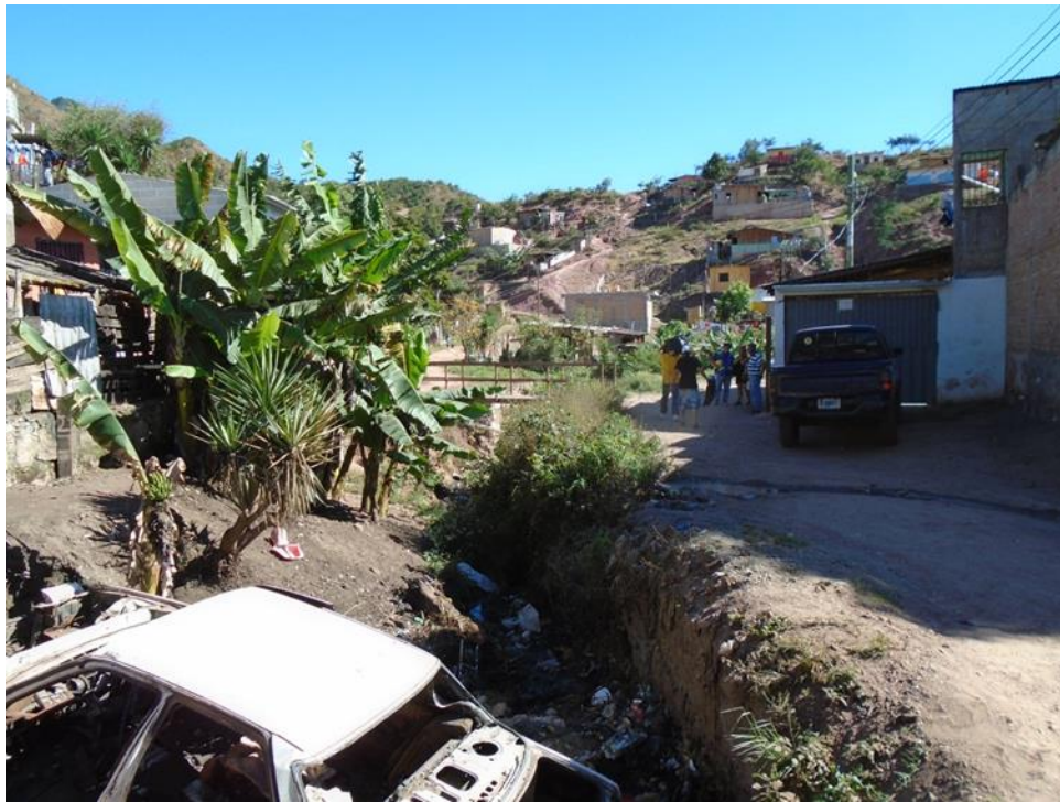
Vista general del sitio donde se construirá canal de mampostería y la caja puente.
