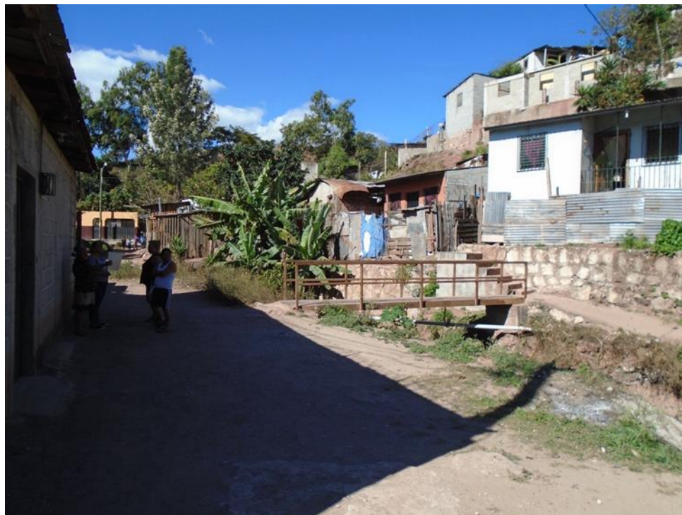
Puente peatonal existente el cual se repondrá por una caja puente
