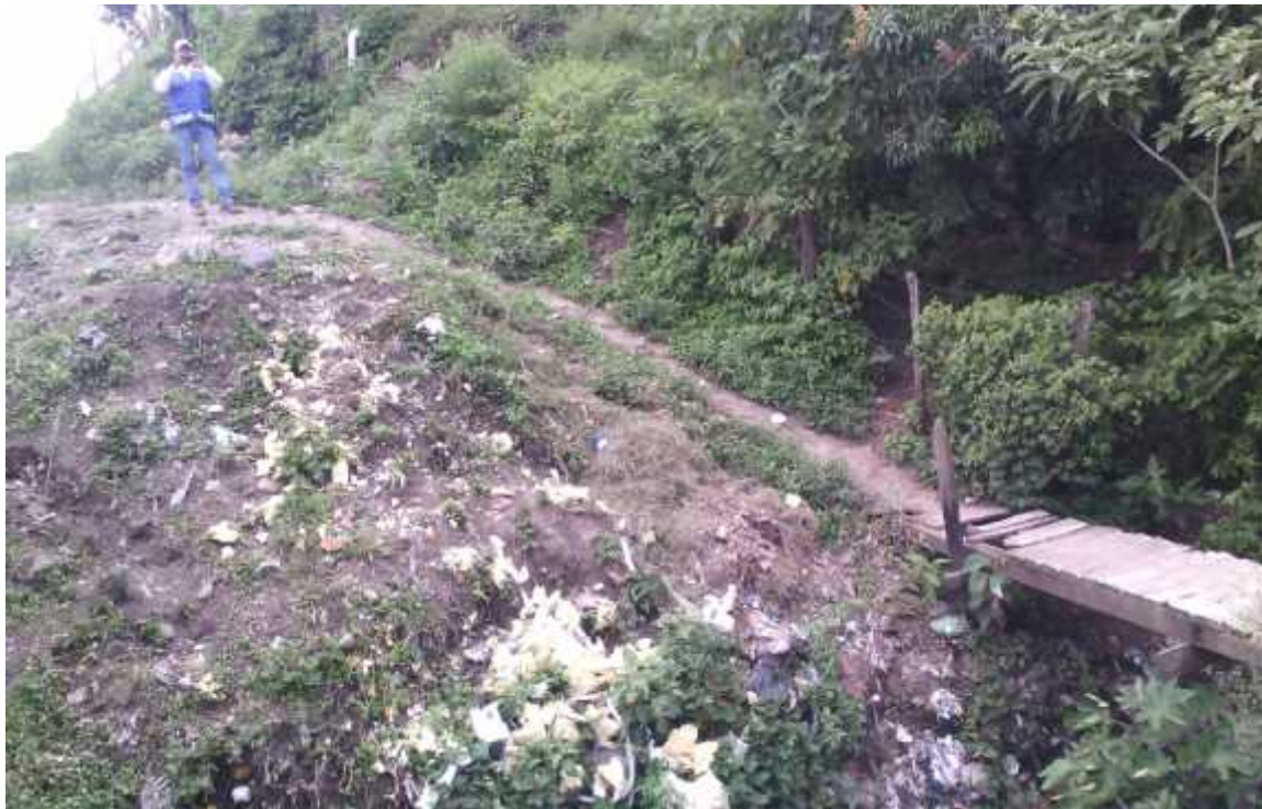
Vista panorámica del puente
