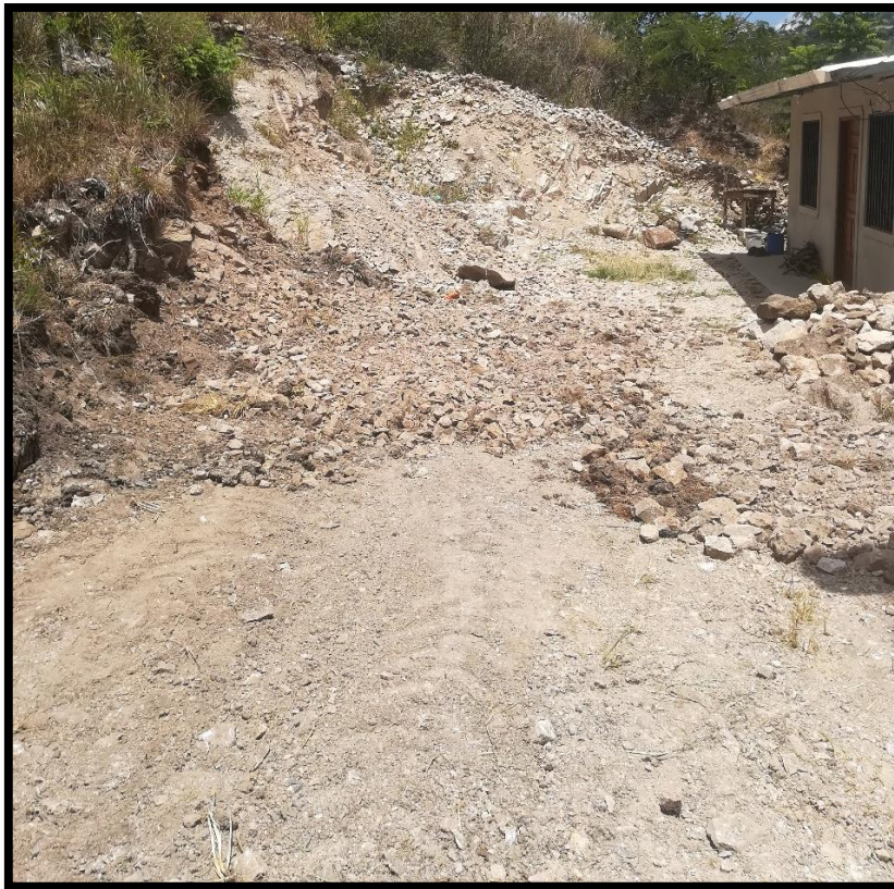
No.4 Vista final de la calle a pavimentar.
