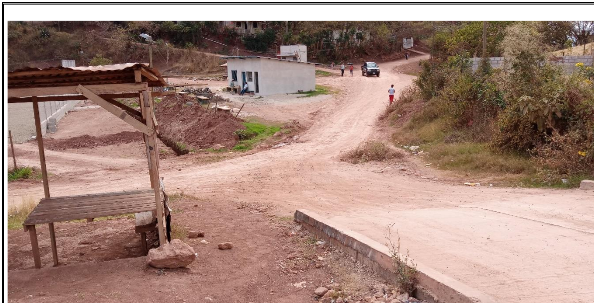
No. 4 PAVIMENTO EXISTENTE AL CUAL SE CONECTARÁ EL TRAMO FINAL DEL PROYECTO Fecha: ENERO 2020
