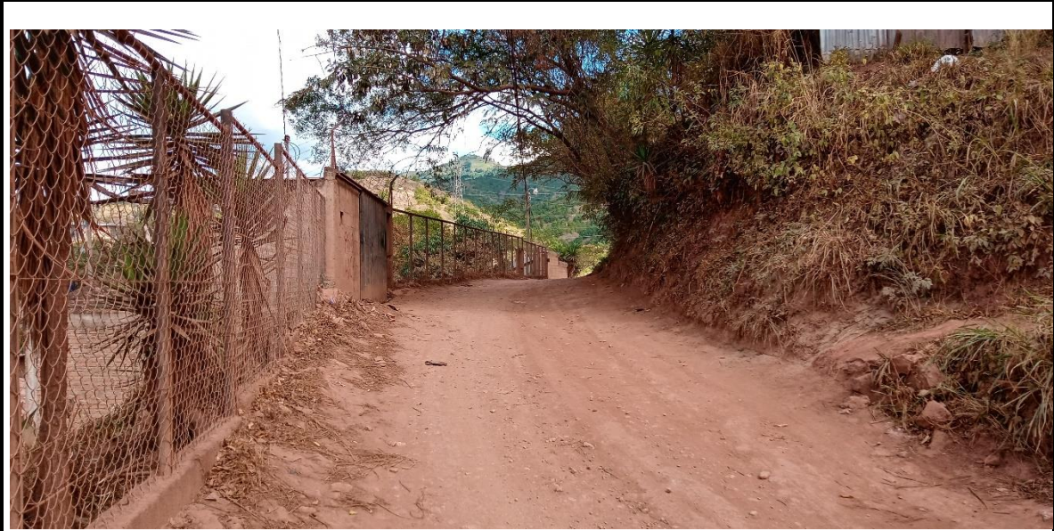
No. 7 TRAMO INTERMEDIO DE CALLE B Fecha: ENERO 2020
