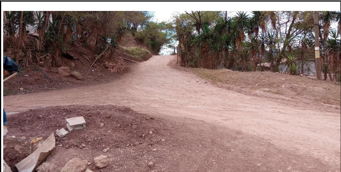
No. 8 FINAL DEL PROYECTO EN CALLE B, EL CUAL SE CONECTARÁ AL PAVIMENTO DE CALLE A Fecha: ENERO 2020
