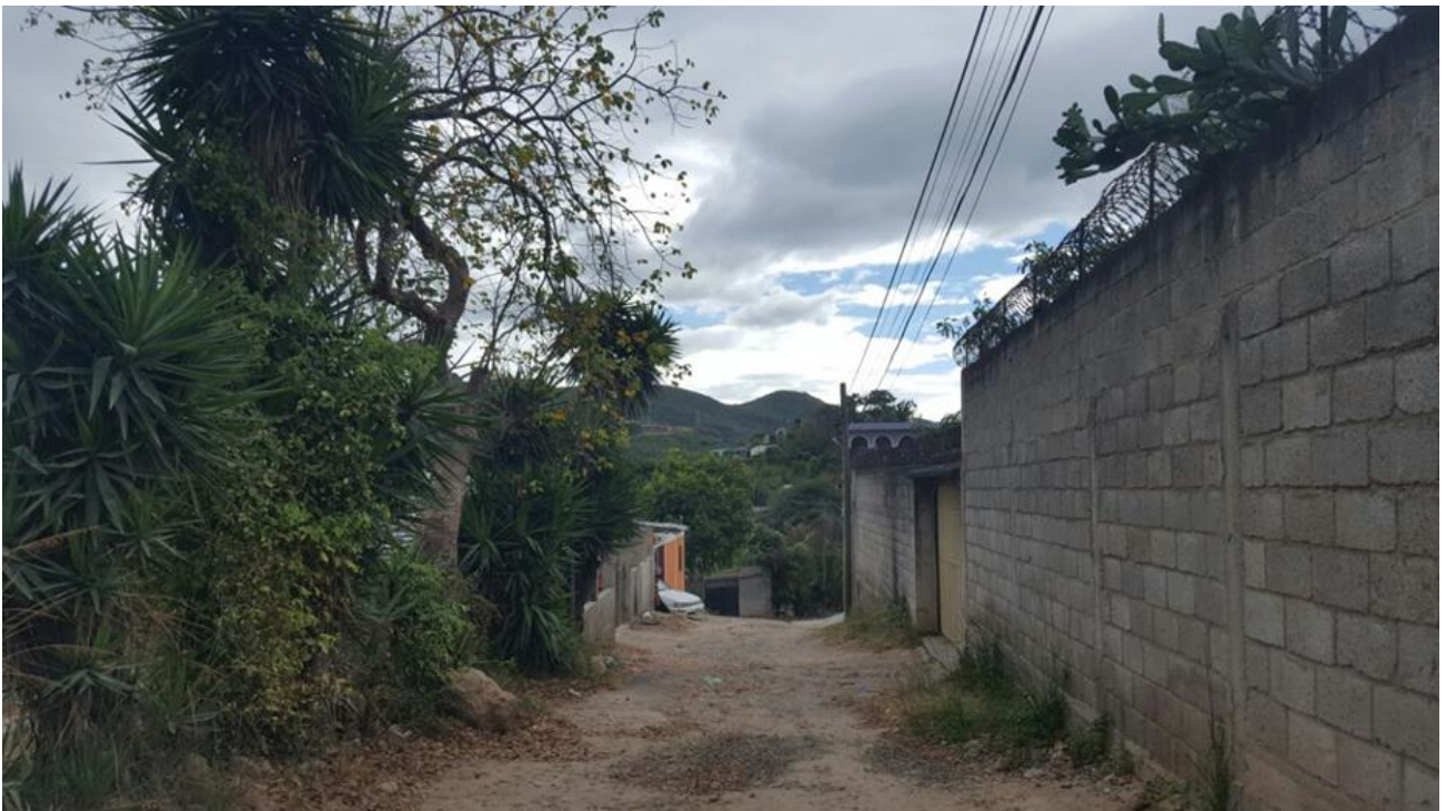
SITIO DONDE FINALIZA LA PAVIMENTACIÓN CON CONCRETO HIDRÁULICO
