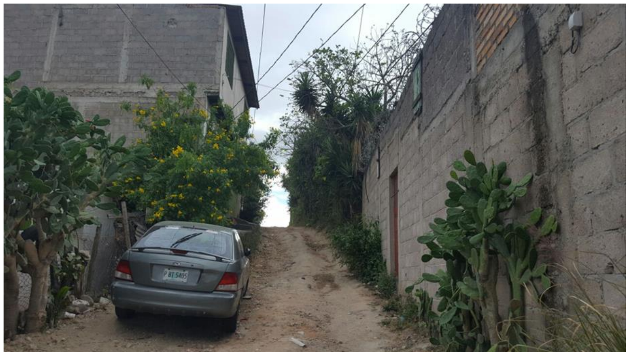
SE OBSERVAN LAS MALAS CONDICIONES DE UN TRAMO DE LA CALLE A PAVIMENTAR
