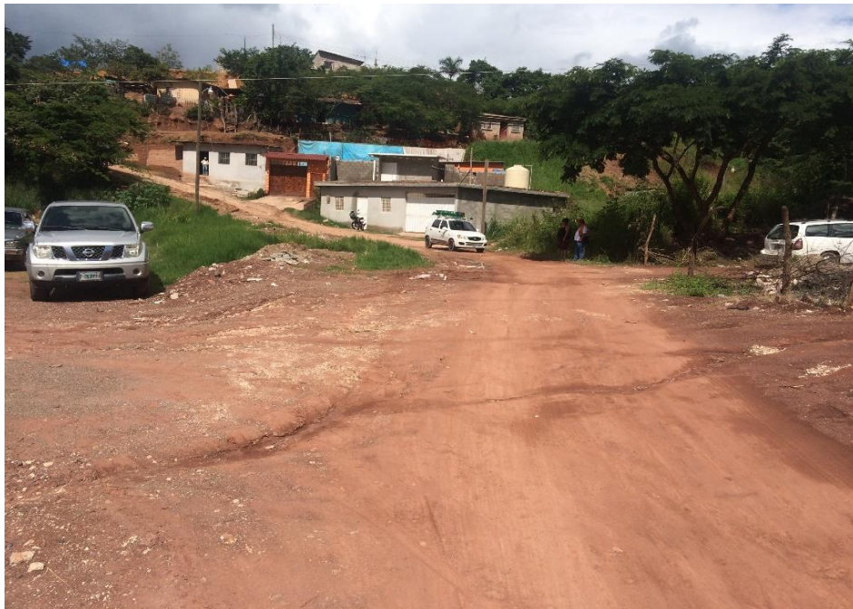
FOTO #2 TRAMO DE CALLE DONDE SE COLOCARÁ DRENAJE.
