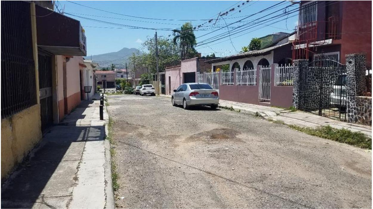
En la imagen se aprecia el desgaste de la calzada existente
