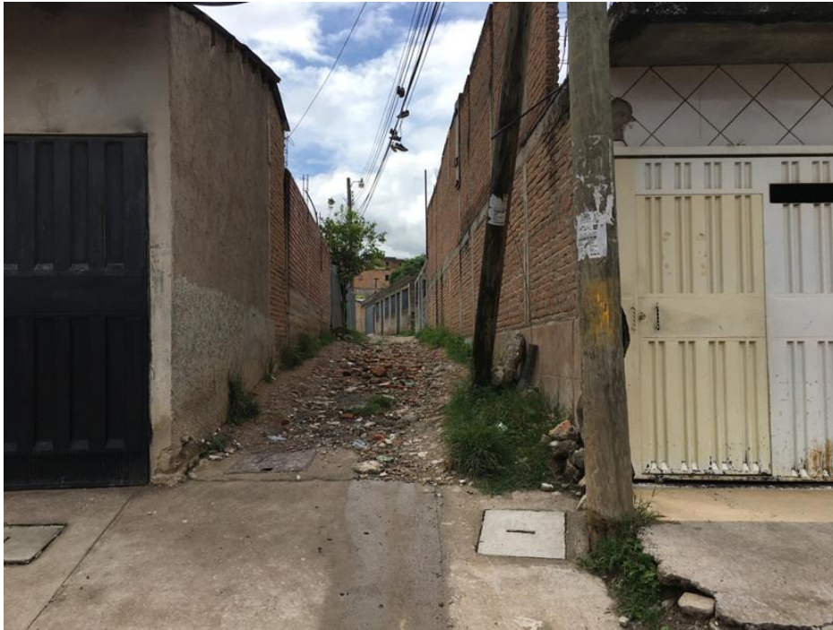
Vista de callejon a pavimentar
