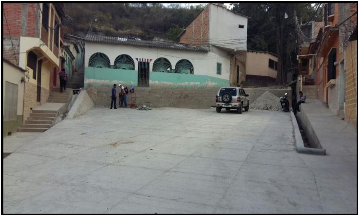
Vista del Área Social en col. Hato de Enmedio Sector 6
