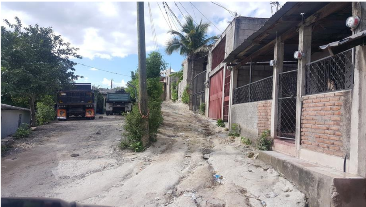
Final de calle a pavimentar
