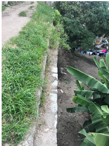
FOTO #2 CONDICIONES ACTUALES DE LA CALLE EN LA ZONA DONDE CONSTRUIRÁ CORONA DE MURO Y MURO DE CONTENCIÓN PARA RETENCIÓN DEL TALUD Y AMPLIACIÓN DE LA CALLE
