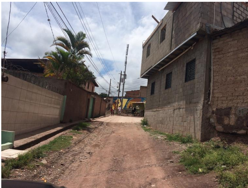
VISTA ESTADO ACTUAL DE CALLE A PAVIMENTAR
