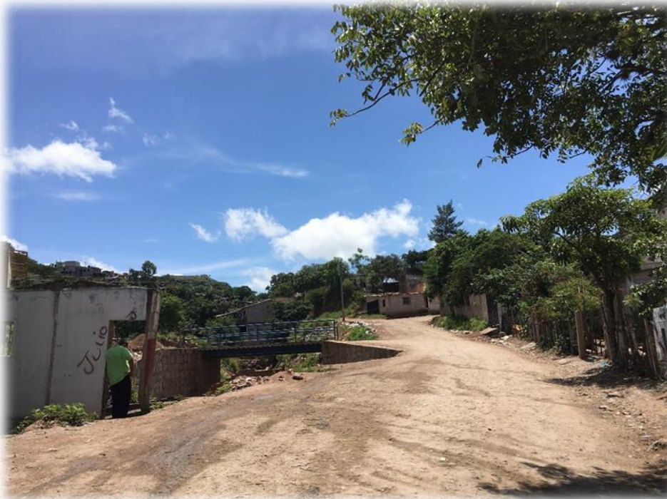
FINAL DE PAVIMENTO CON CONCRETO HIDRÁULICO
