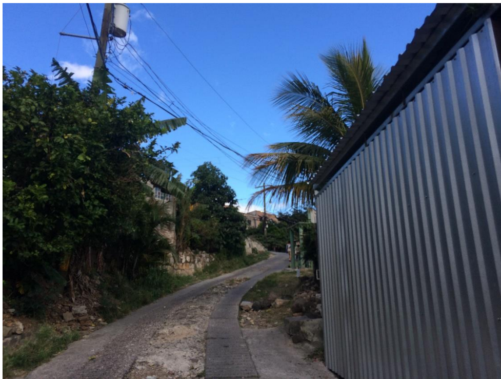
Vista de calle a reparar
