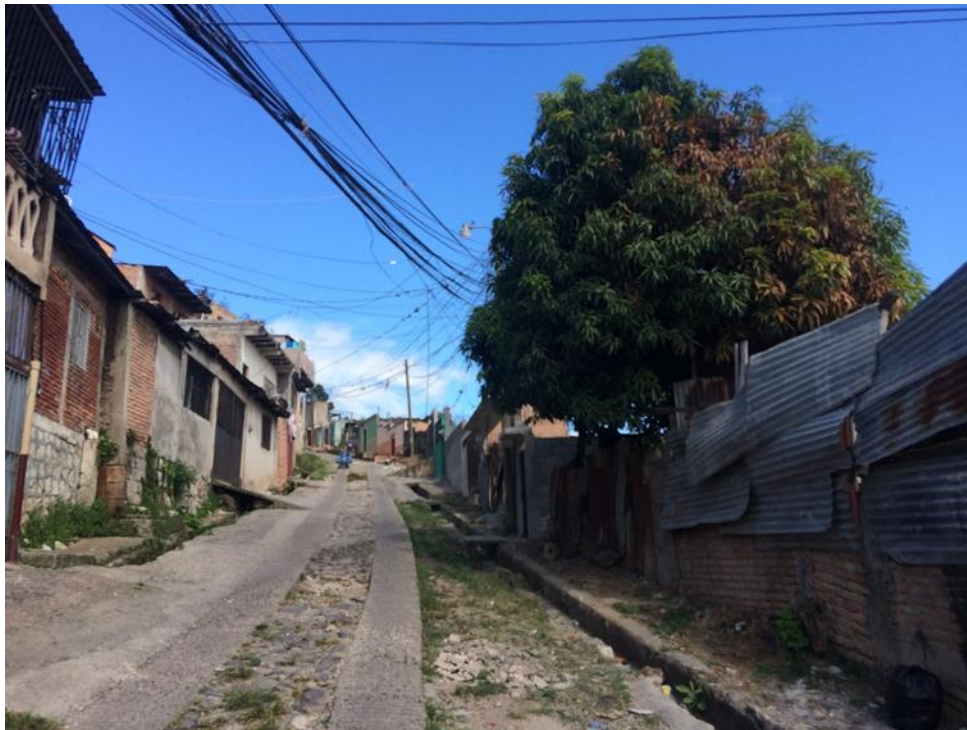
Inicio de calle a pavimentar tramo 2
