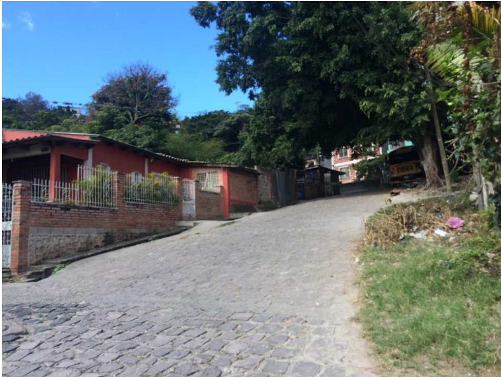
Vista de calle a pavimentar con concreto hidráulico tramo 3
