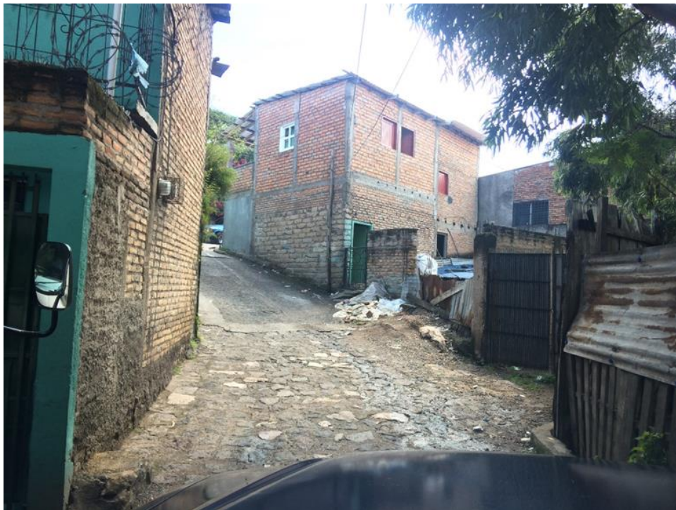
Final de calle a pavimentar tramo 1
