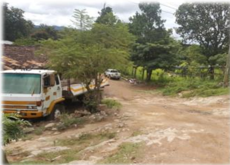
FINAL DE CALLE EN LA QUE SE HARÁ EL BALASTADO
