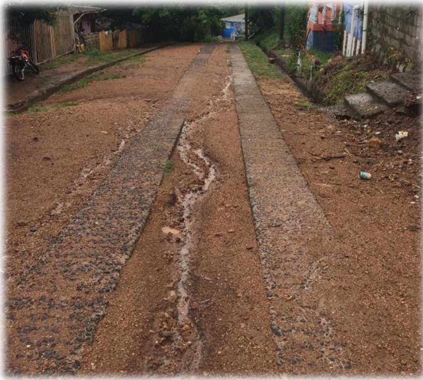
VISTA DE HUELLAS A DEMOLER Y FINAL DE CALLE A PAVIMENTAR
