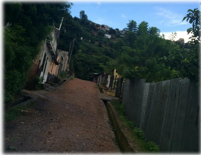
VISTA DE CALLE A PAVIMENTAR
