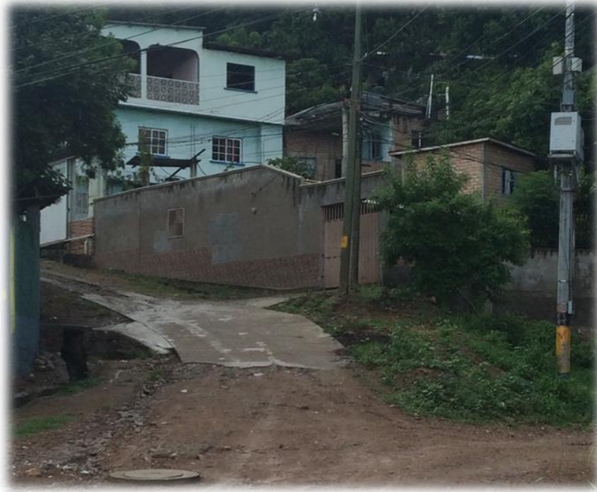
INICIO DE PAVIMENTACIÓN CON CONCRETO HIDRÁULICO
