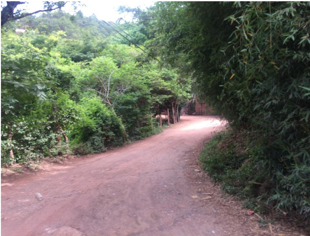
INICIO DE CALLE A REPARAR
