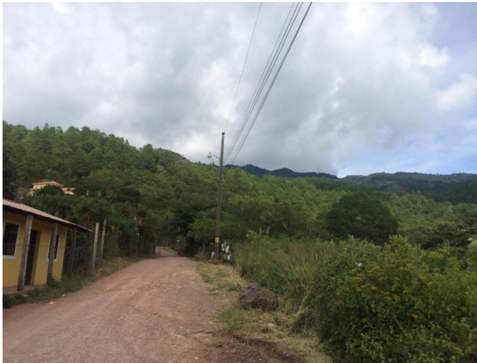
VISTA PANORÁMICA DE CALLE A REPARAR
