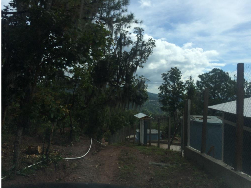
FINAL DE CALLE A REPARAR
