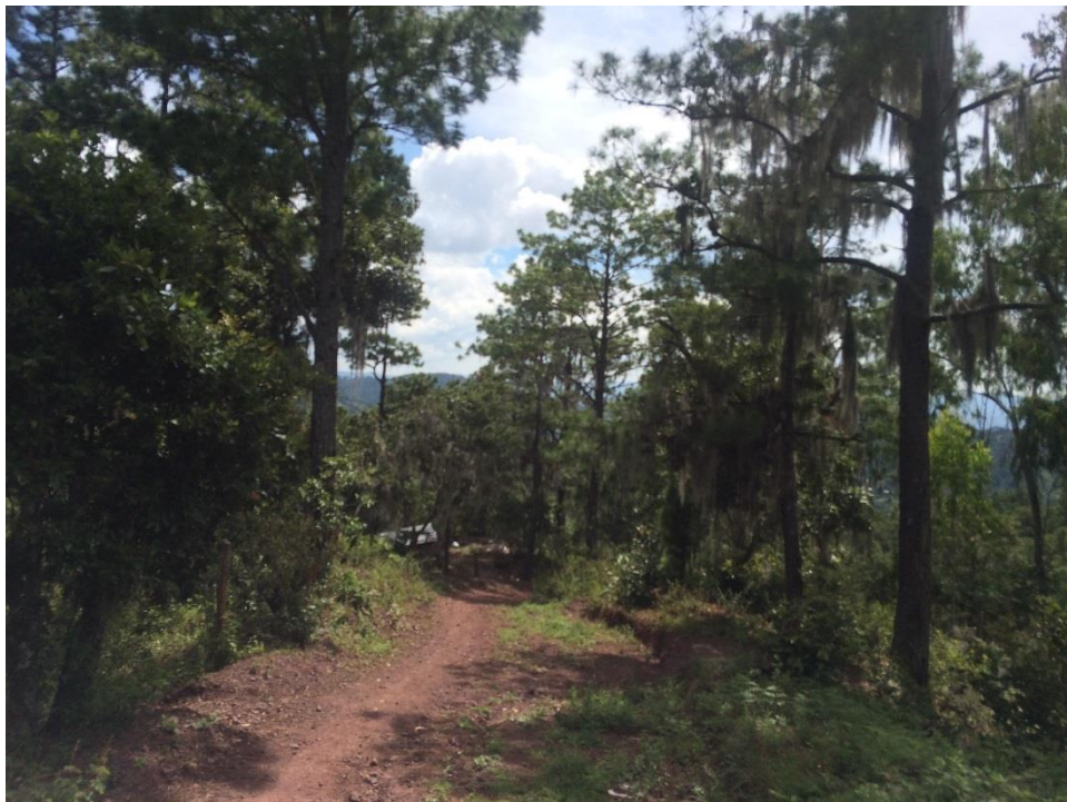
VISTA PANORÁMICA DE CALLE A REPARAR
