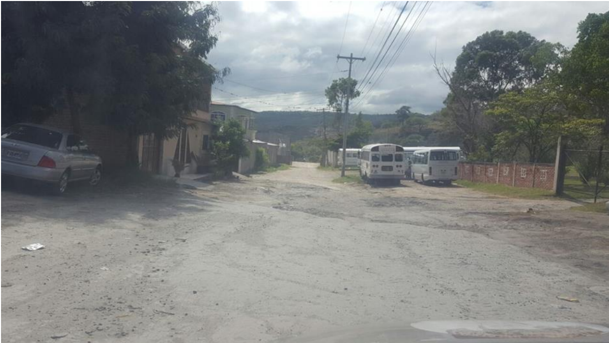
INICIO DE CALLE A PAVIMENTAR CON CONCRETO HIDRÁULICO
