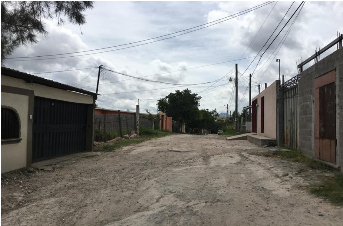
PANORÁMICA DE CALLE A PAVIMENTAR CON CONCRETO HIDRÁULICO
