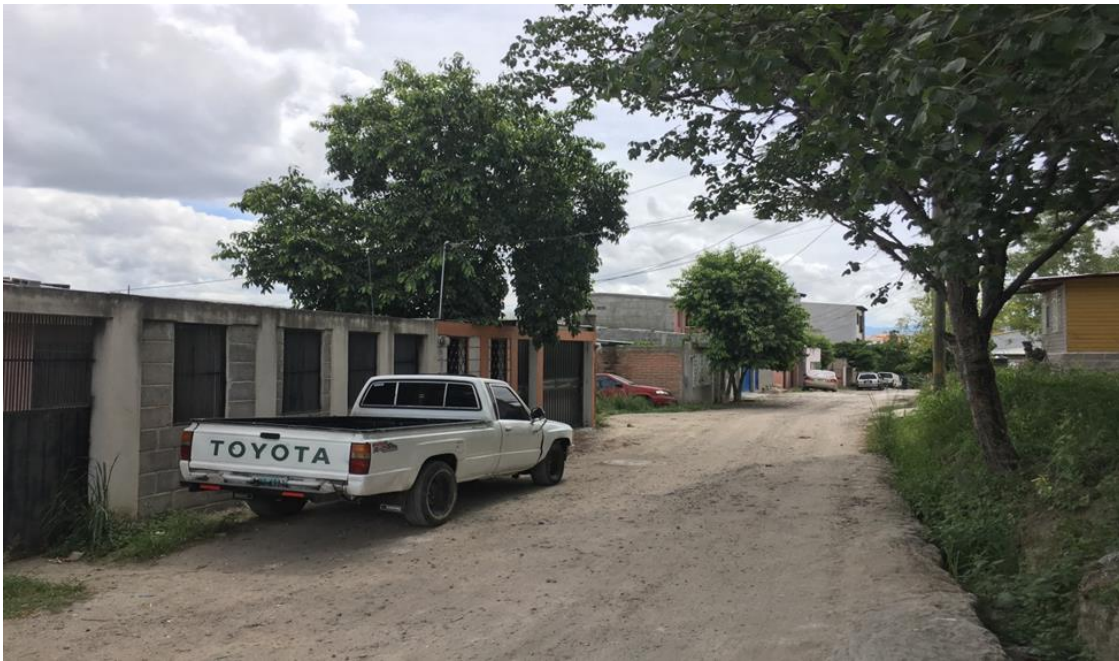
VISTA DE LA CONTINUACIÓN DE CALLE A PAVIMENTAR CON CONCRETO HIDRÁULICO
