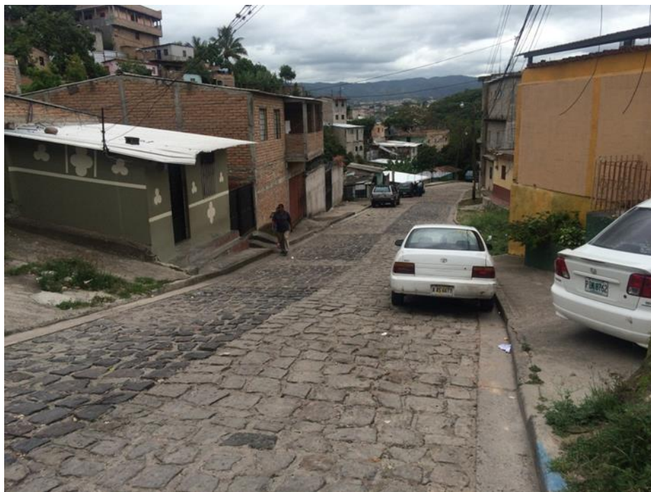
Panorama de calle a pavimentar con concreto White topping
