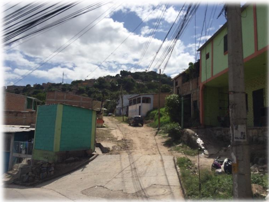
Inicio de pavimentación con concreto hidráulico, tramo A
