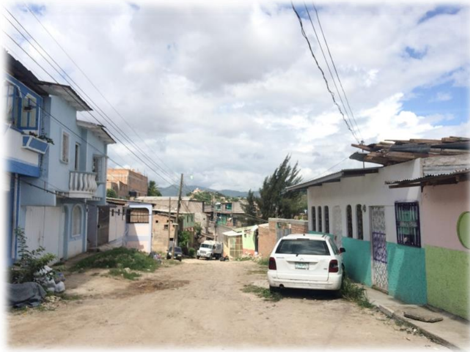
Vista del tramo a pavimentar con concreto hidráulico
