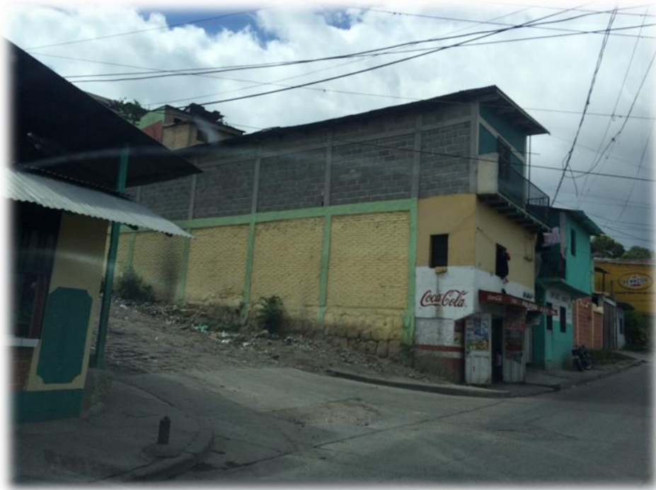
Inicio de white topping tramo B
