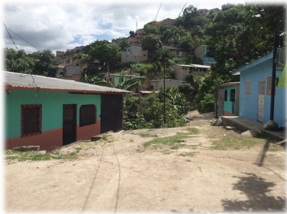
Final de pavimentación con concreto hidráulico, tramo A
