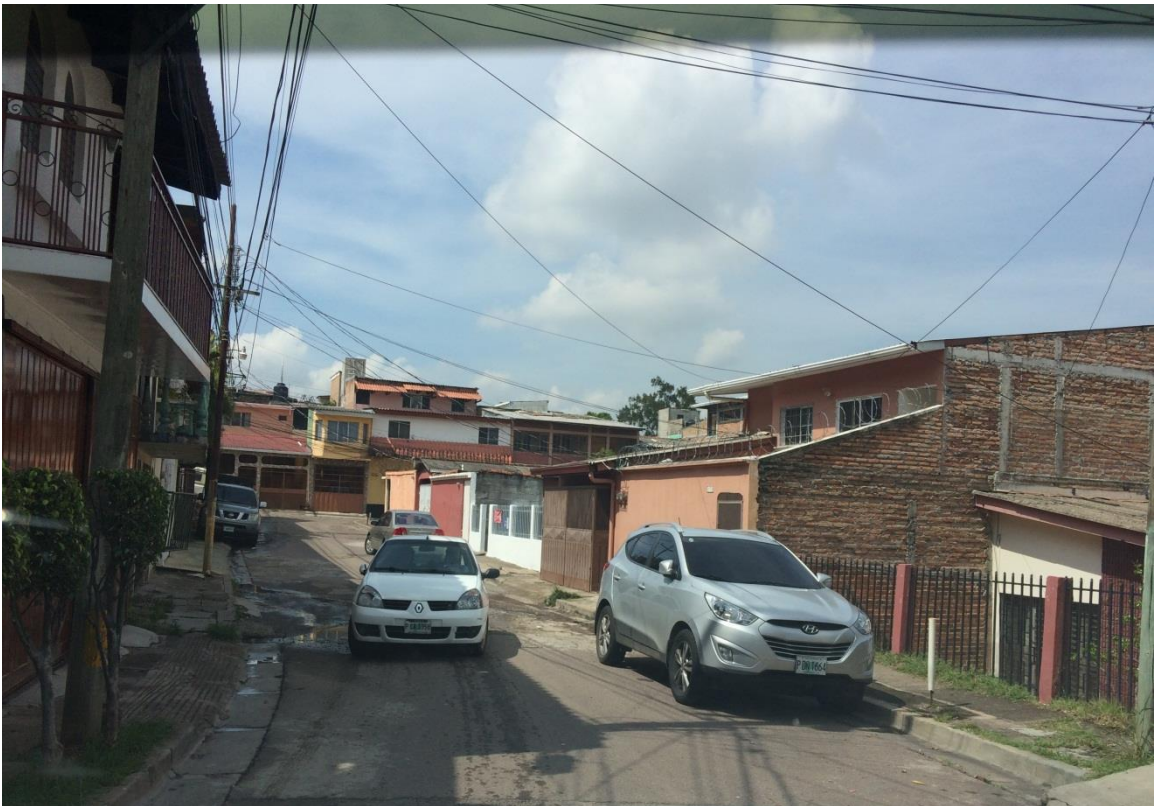
Final de calle a pavimentar
