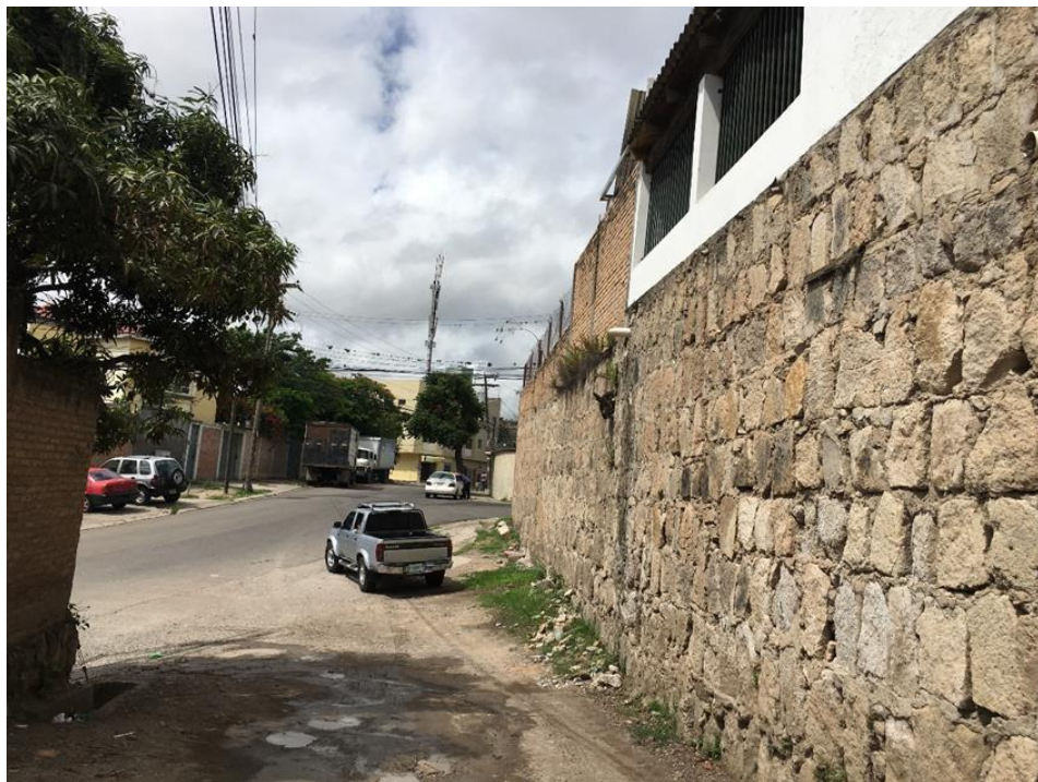
Final del tramo a pavimentar con concreto hidráulico
