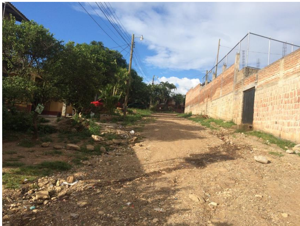
Panorámica de calle a pavimentar con concreto hidráulico
