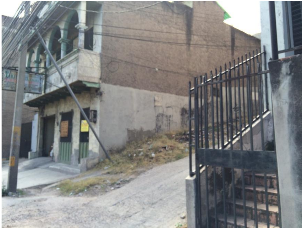
Inicio de calle a pavimentar con concreto hidráulico calle No.2
