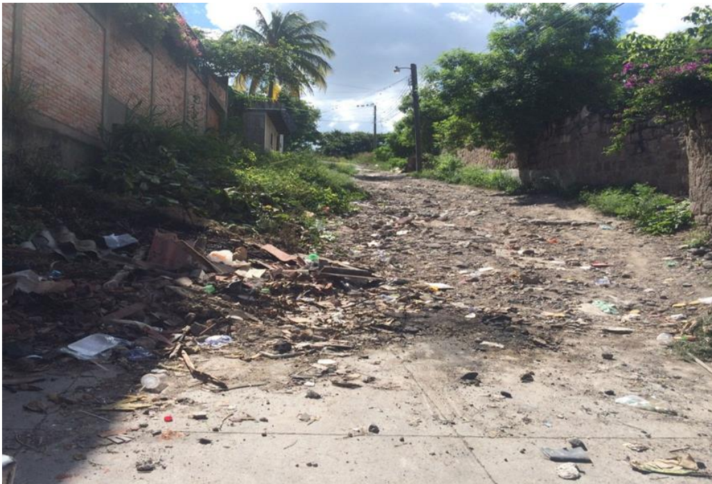
Inicio de calle a pavimentar en la calle No.1
