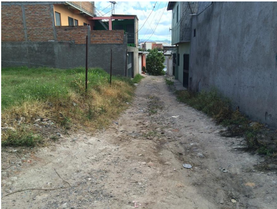
Vista de calle a pavimentar calle No.2
