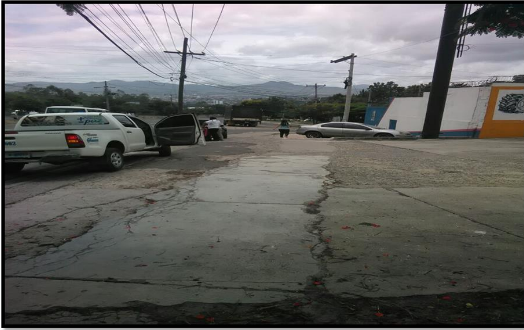
Calle donde se instalara nueva tubería
