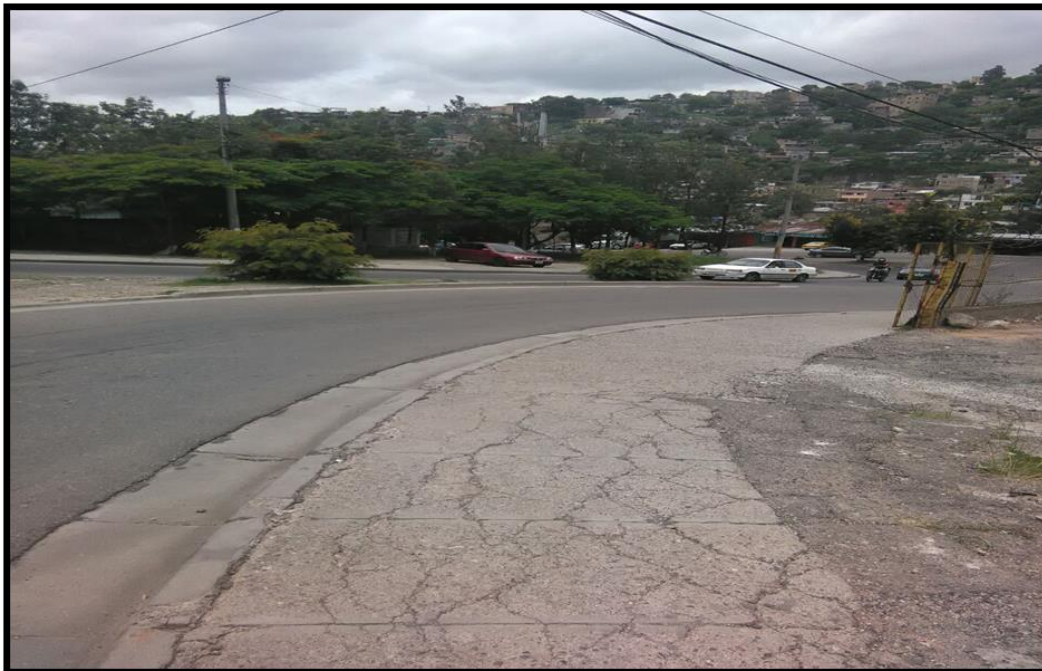
Acera donde se instalara nueva tubería
