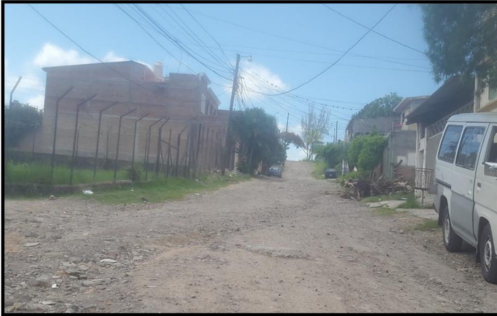
Calle donde se instalara la Tubería
