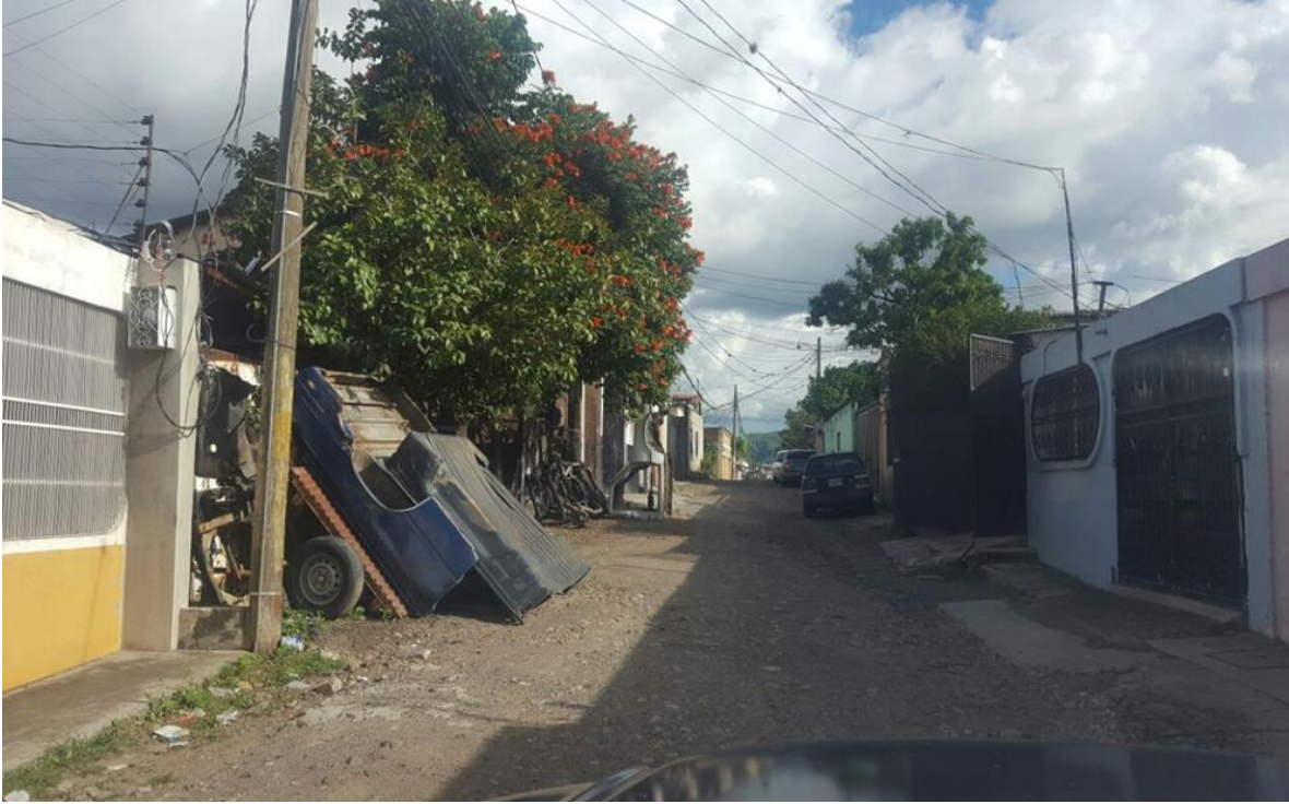
CALLES A PAVIMENTAR CON CONCRETO HIDRÁULICO
