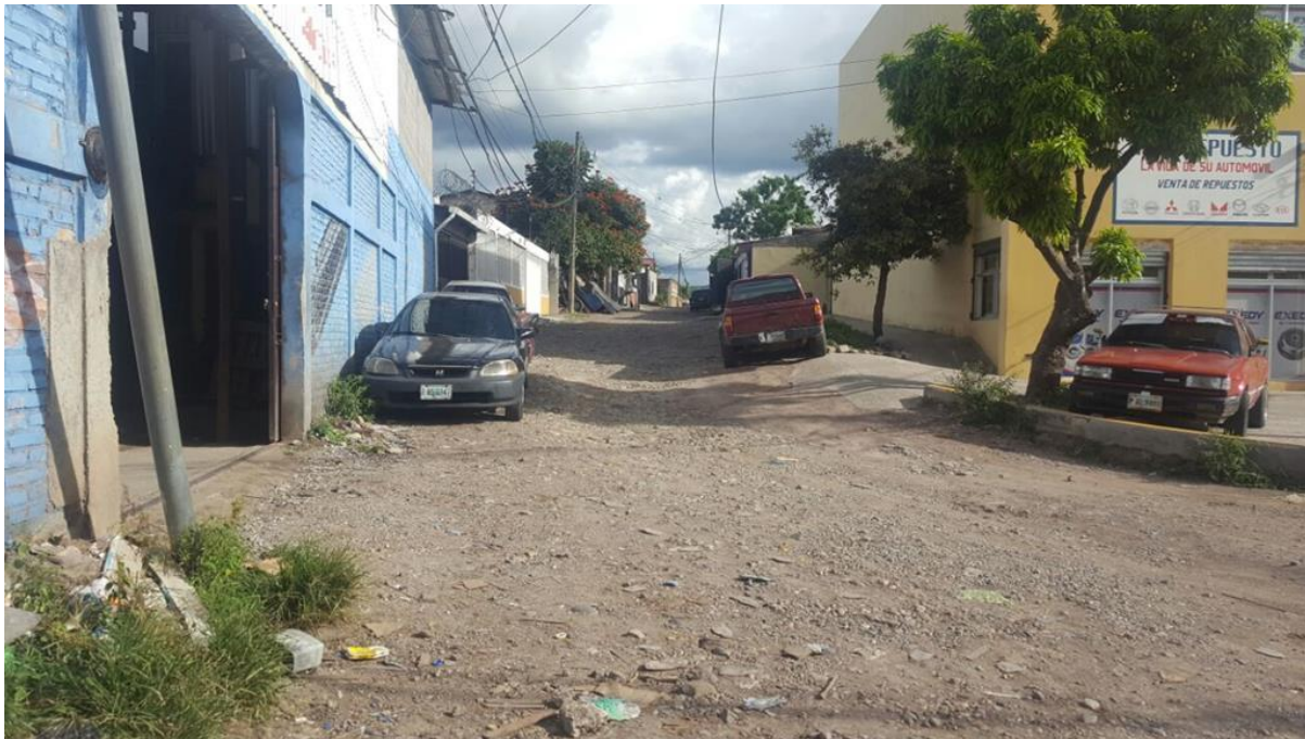
PANORAMA DE CALLES A PAVIMENTAR CON CONCRETO HIDRÁULICO
