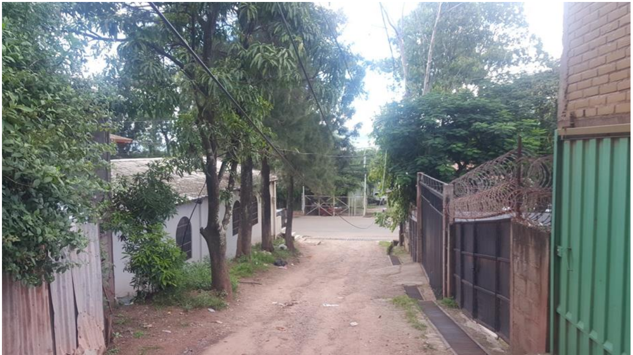
Inicio de calle a pavimentar
