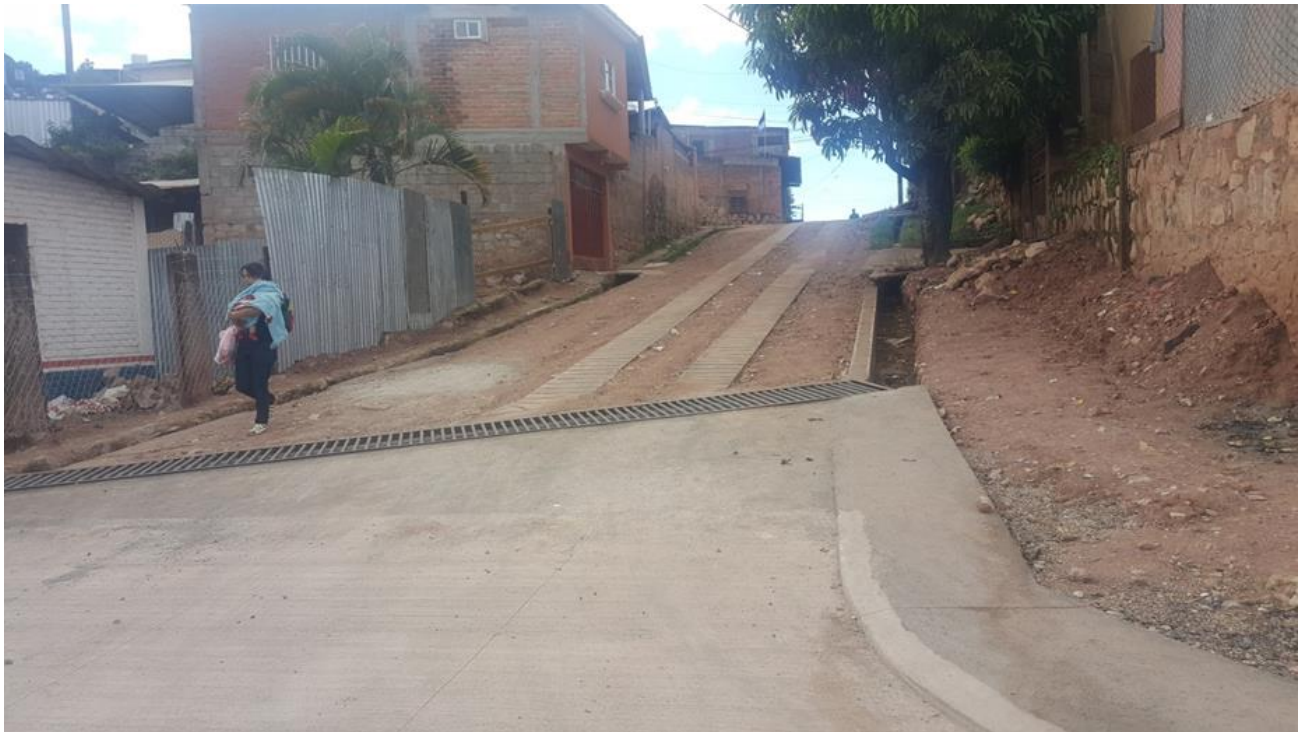
Final 1 de calle a pavimentar
