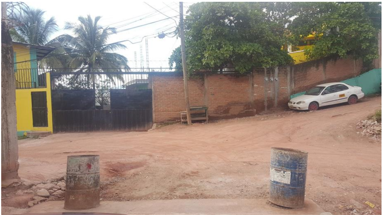
Final 2 de calle a pavimentar
