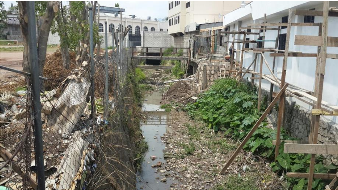
VISTA PANORAMICA DONDE SE VA A CONSTRUIR EL EMBAULADO
