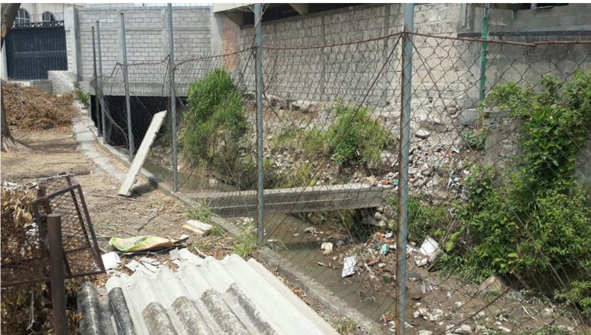
ESTADO ACTUAL DE LA ZONA DE LA QUEBRADA
