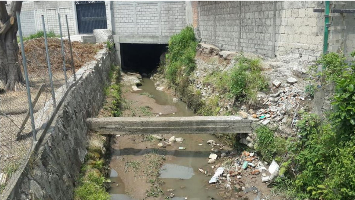
VISTA DE LA VIGA QUE SERA REMOVIDA PARA LA CONSTRUCCION DEL EMBAULADO
