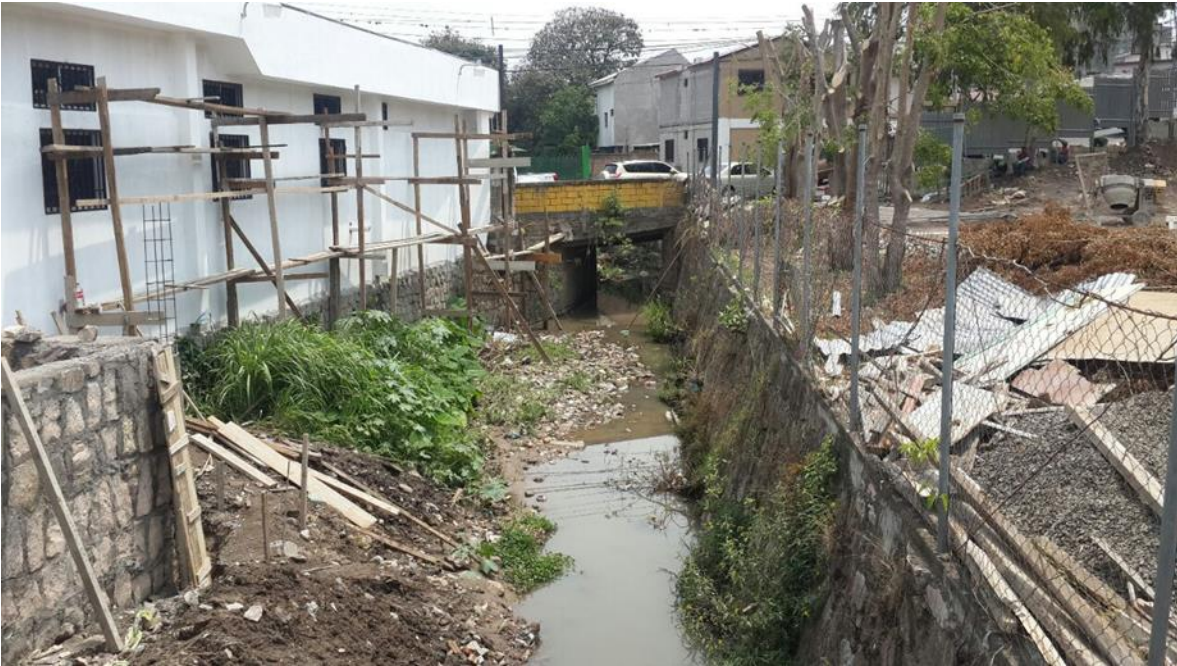
VISTA DE DONDE SE CONSTRUIRA EL EMBAULADO
