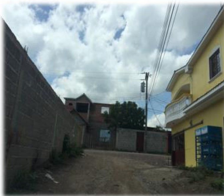
FINAL DEL TRAMO DE CUNETA
