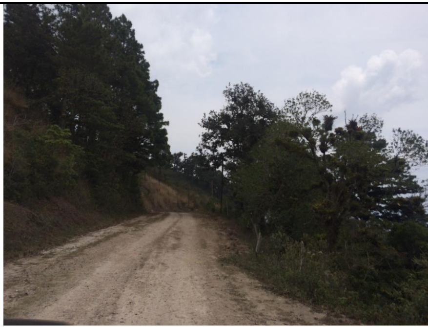
Condiciones actuales de otro tramo de la calle a conformar y balastar
