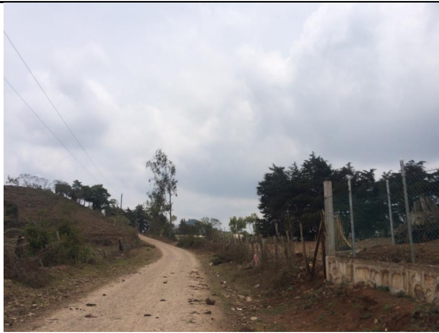
Condiciones actuales de calle a conformar y balastar
