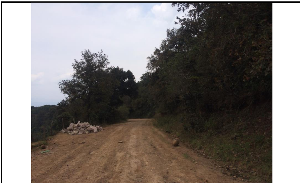
Se observan las malas condiciones de la calle
