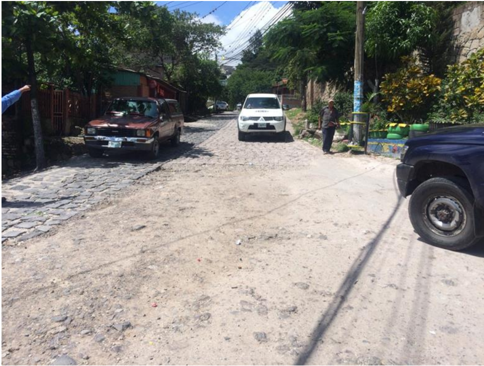
Inicio de calle a pavimentar con white topping
