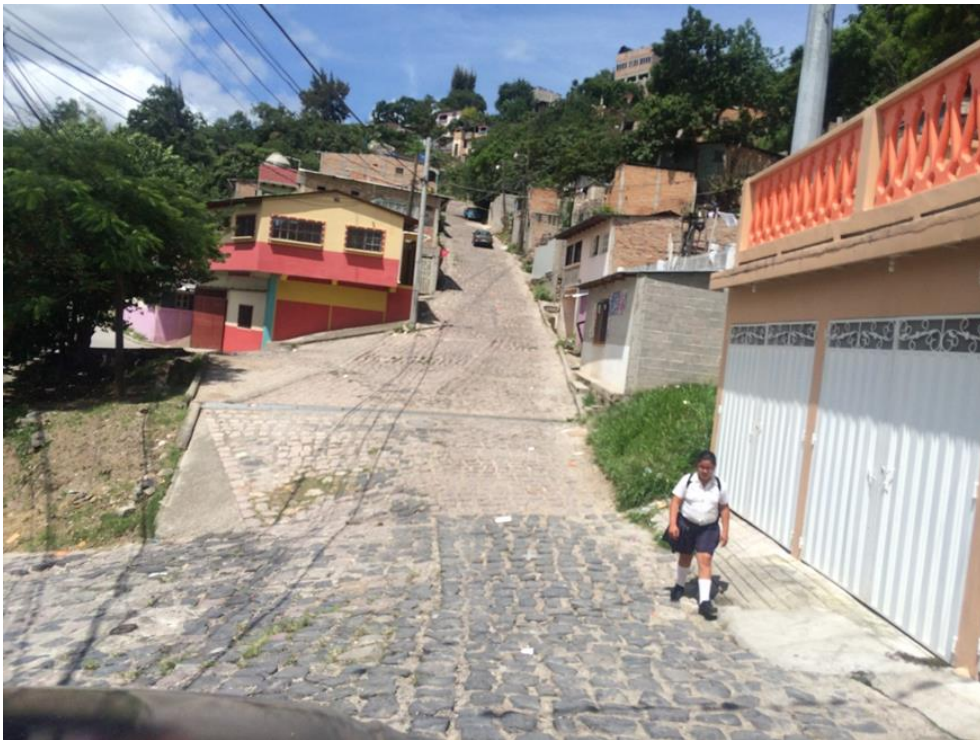
Vista de calle a reparar el empedrado
