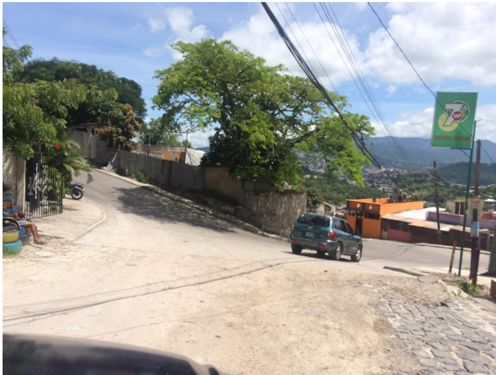
Final de calle a pavimentar con white topping
