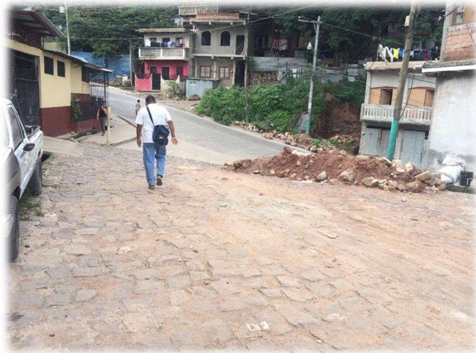
INICIO DE PAVIMENTACION
