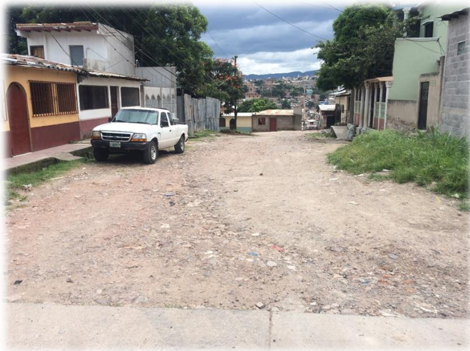
FINAL DE PAVIMENTACIÓN
