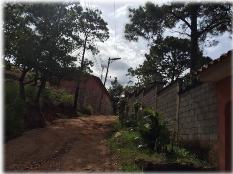
INICIO DE CALLE EN LA QUE SE HARÁ EL BALASTADO
